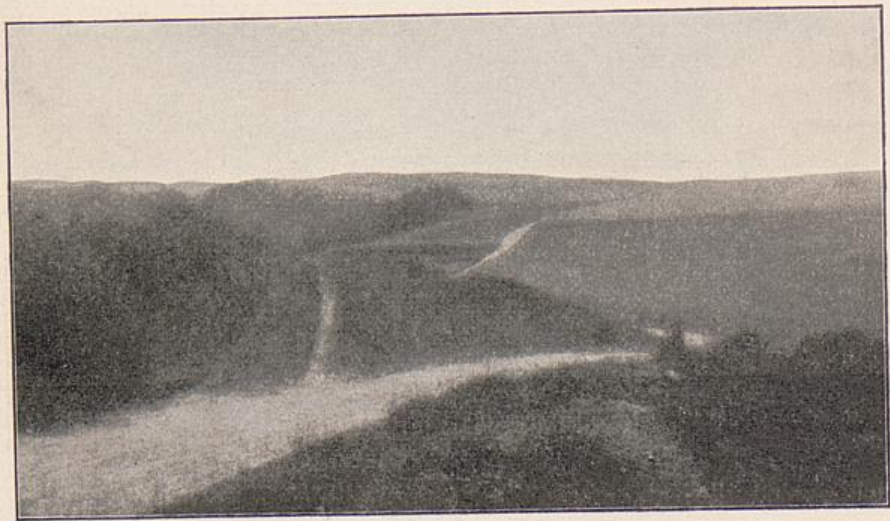
Abb. 20. Straße bei Wüstenstein.
