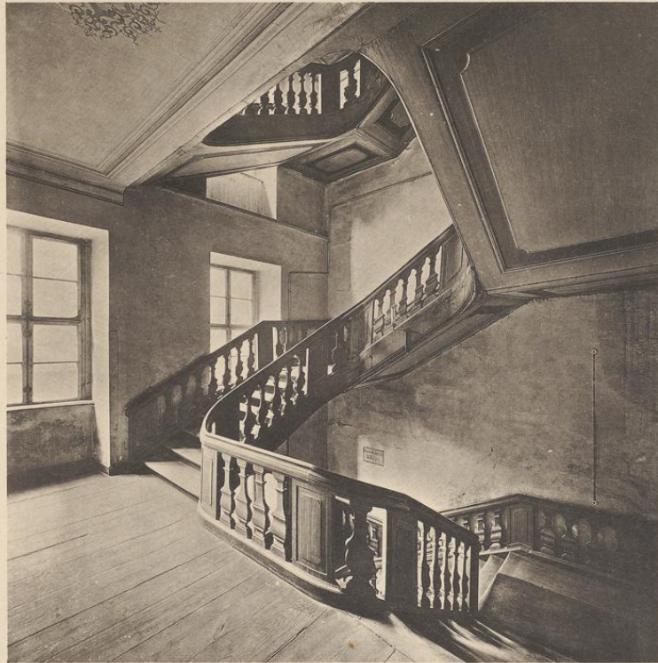
An der Fischerbrücke 18 (siehe Tafel 24, 25)
