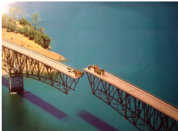
Abb. 2.3.2 Präzision bei der Orientierung der beiden Enden (im Modell).
