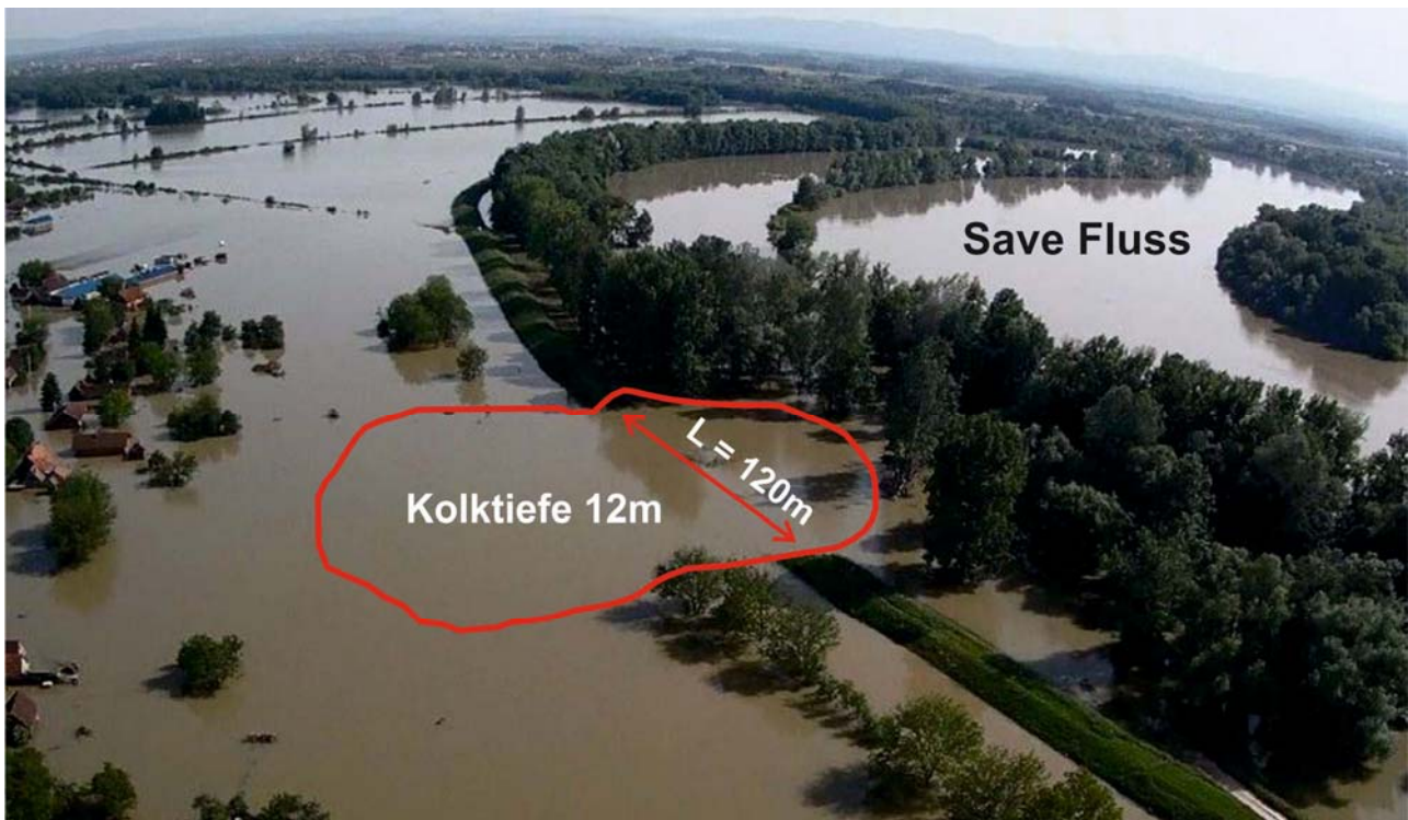
Abb. 17: Luftbild der Dammbuchstelle am Save-Hochwasserschutzdamm in Rajevo Selo (Kroatien) mit eingezeichnetem Auskolkungsbereich.
