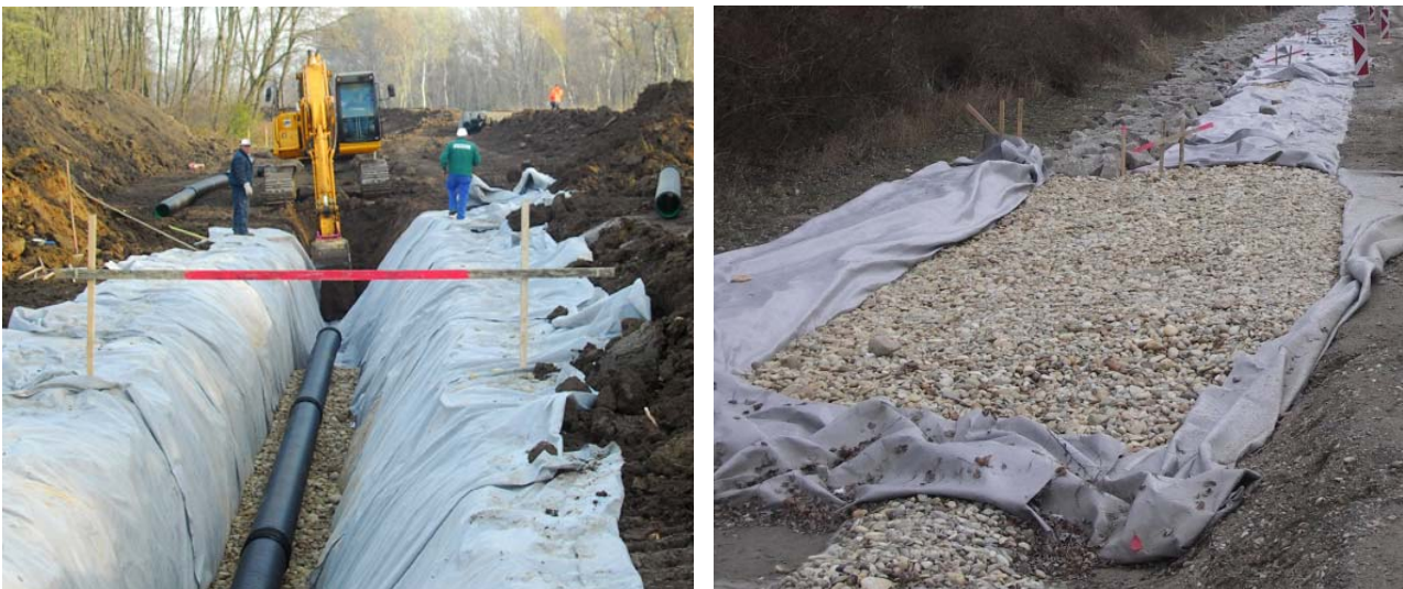
Abb. 9: Herstellung des Entlastungsgrabens mit Vliesummantelung und eingebautem Drainagerohr zur gezielten Ableitung der Sickerwässer.
