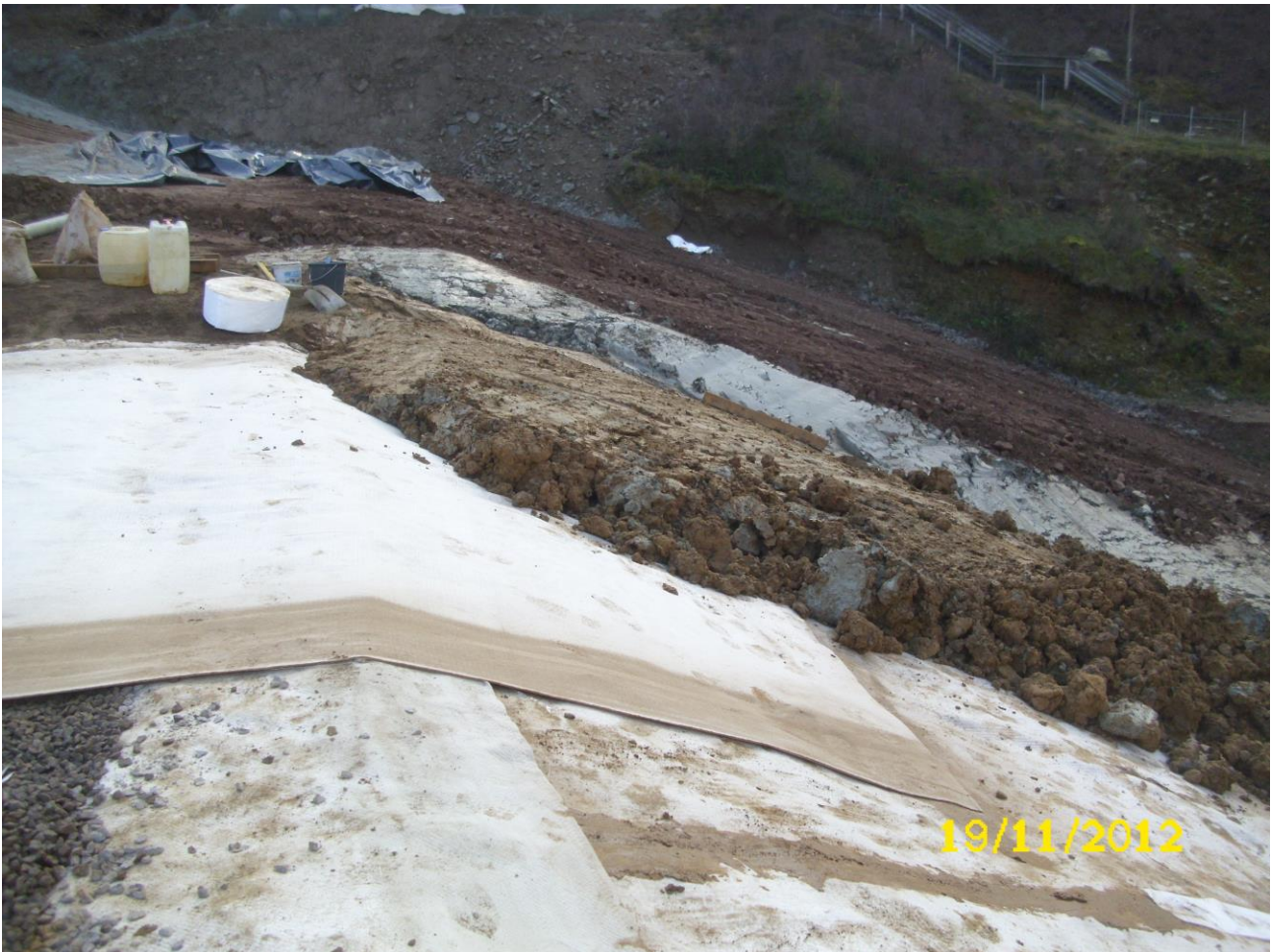
Abb.7: Einbindung der Bentonitmatten in die min. Dichtung (Foto Hagenloch)
