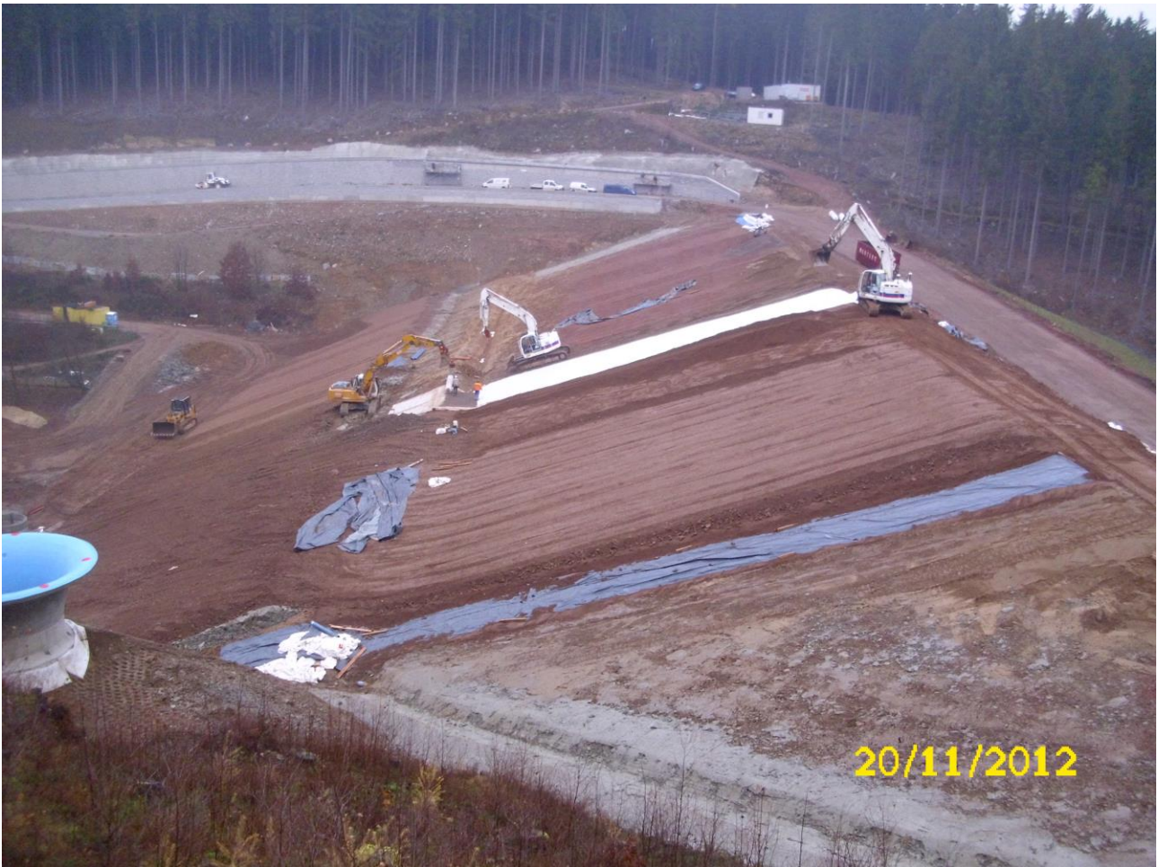
Abb. 3: Sicht auf das Baufeld vom rechten Hang
