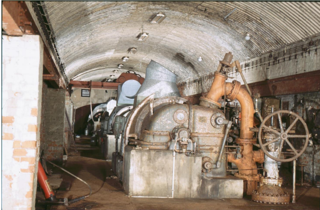
Abb. 14: Das 1980 stillgelegte Kraftwerk Wilhelmschacht heute.
