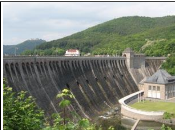
Abb. 1: Edertalsperre Ausmündung Zwischenauslässe (Foto: HAUFE)
