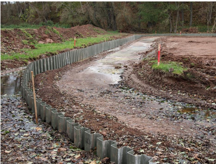
Abb 6: fertiggestellte Kunststoffspundwand
