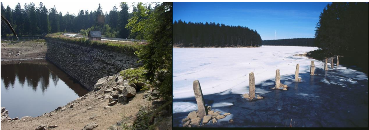
Abb. 16: Oderteich. 1 Granitmauerwerk der Wasserseite. 2 Eisabweiser vor dem Hochwasserüberlauf
