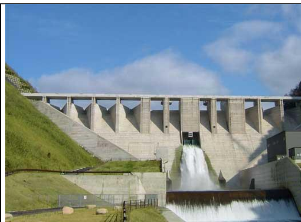
Abb. 11: Tomata Talsperre Zwischenauslässe ( www.damnet.or.jp )
