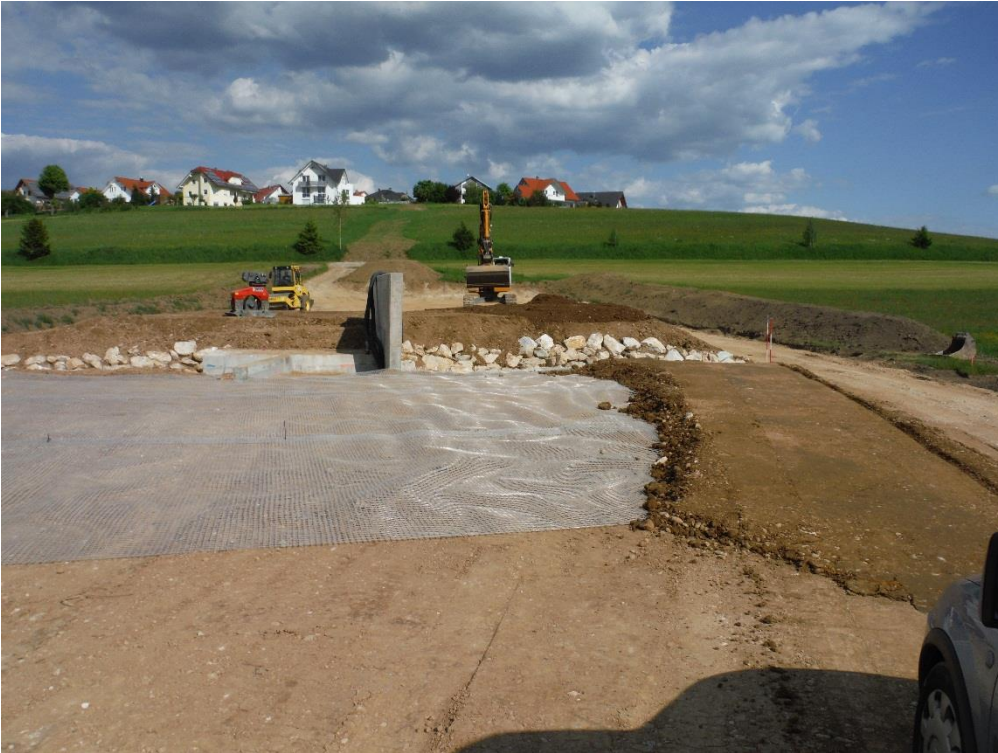
Abb. 8: Einbau der vierten Geogitterlage. Als Geogitter wurde ein Produkt mit hoher Dehnsteifigkeit und Alkalibeständigkeit verwendet.
