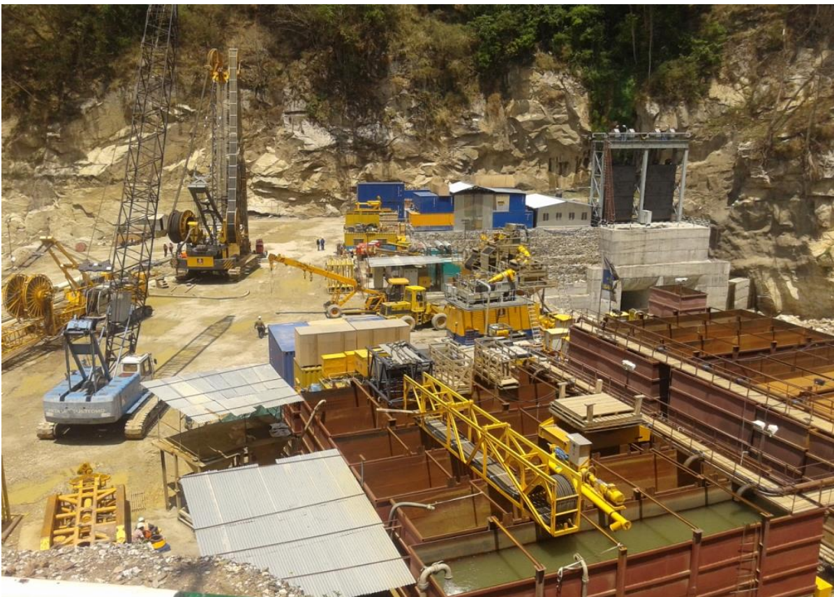
Abb. 9: Mangdechu HEP – Herstellung der gefrästen Schlitzdichtwand
