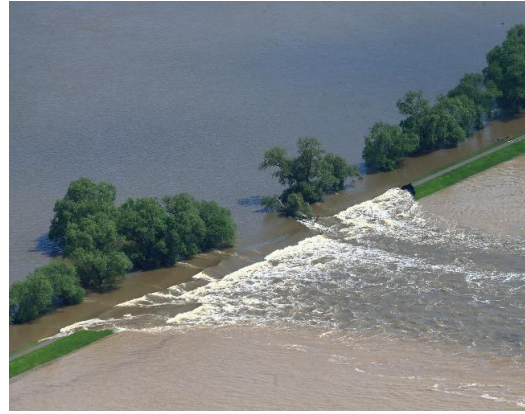
Abb. 10: Deichbruch bei Breitenhagen/Saale (Quelle: n24)
