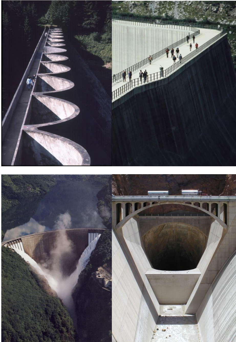
Abb. 15: Moderne Talsperren 1: Linach/Schwarzwald 2: Albingia/Graubünden. 3: Verzasca/Tessin (Foto: Verzasca AG); 4: Hochwasserüberlauf Hoover/USA.
