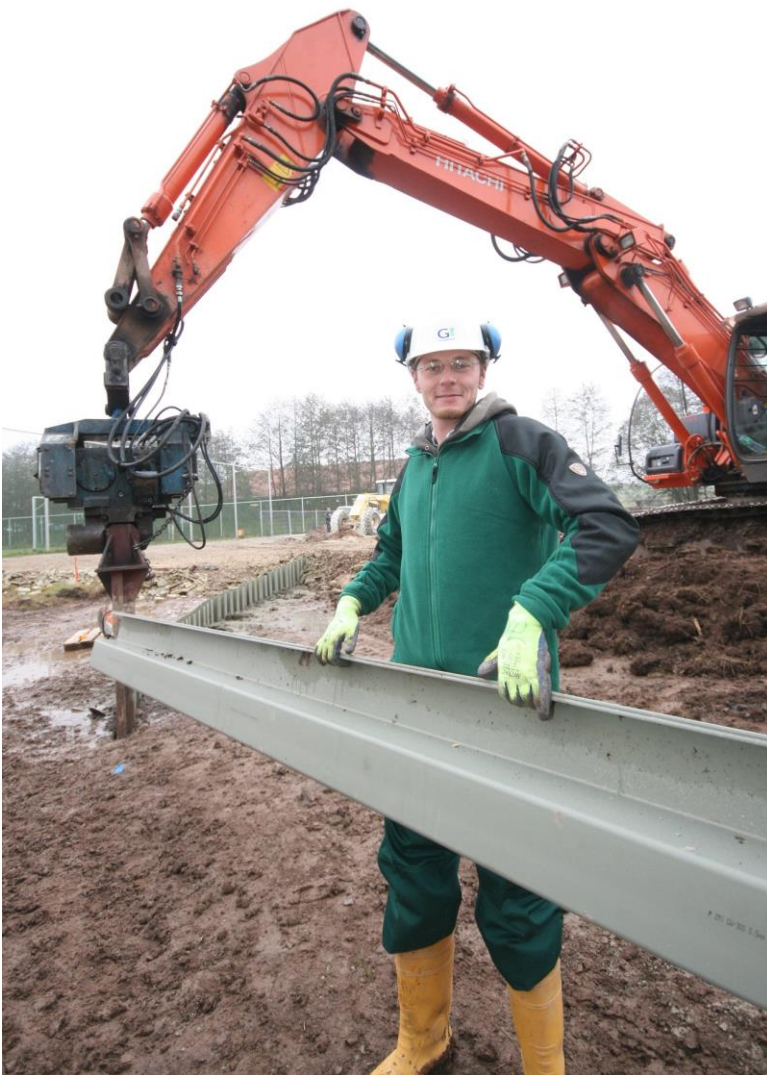
Abb. 1: Einfache Handhabung der Kunststoffbohlen auf der Baustelle
