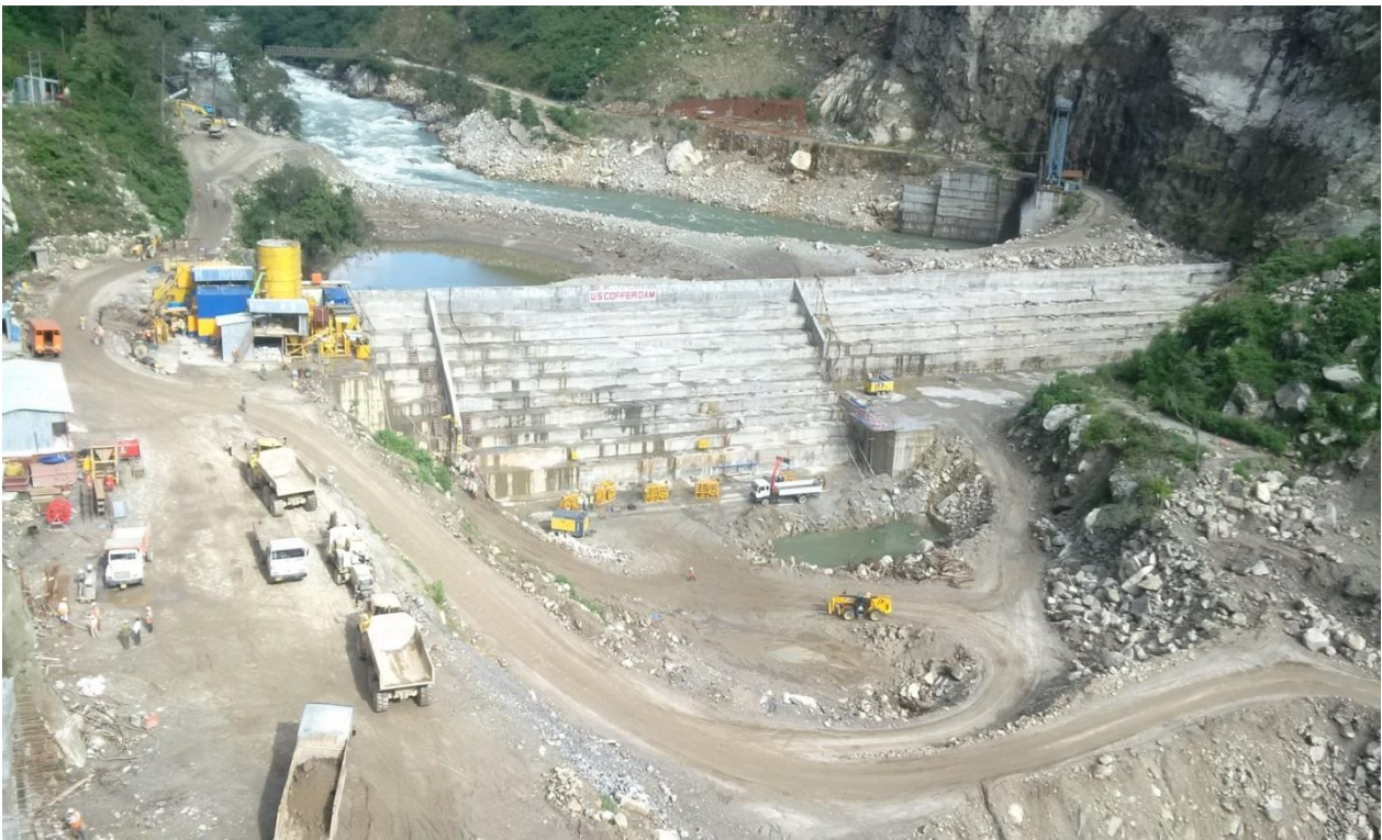
Abb. 7: Punatsangchu-2 HEP – Herstellung des Dichtungsschleiers
