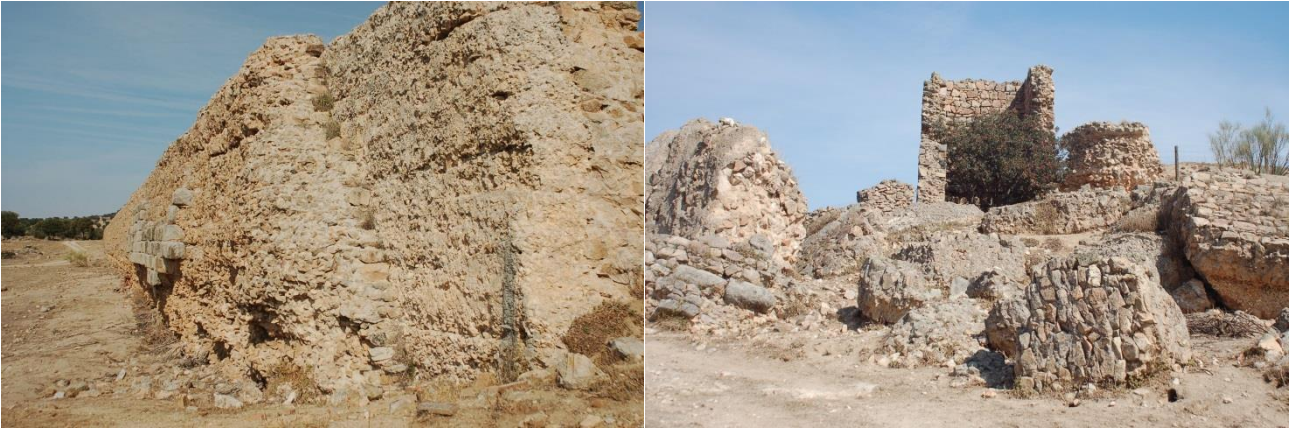
Abb. 9: Talsperre Alcántara: lks.: Wasserseite der Stauwand mit Fassadenmauerwerk, Zwischenschicht und Betondichtung (rechts) re.:Entnahmeturm
