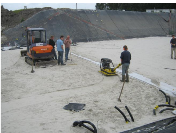
Abb. 5: Einbau des Geotextils in Sandschicht, vor Aufbau des Kleideichs (links) und Blick auf den Deich bei vollständig gefülltem Bassin am Ende des Versuchs. An der unterstromigen Seite sind nur wenige Sandkrater zu erkennen.
