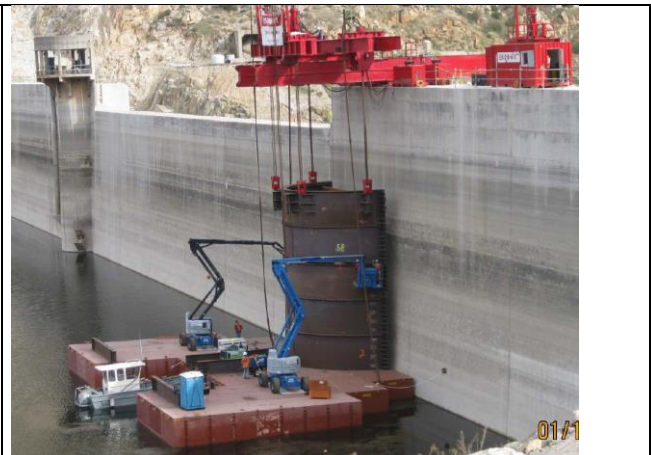
Abb. 14: Temporärer wasserseitiger Verschluss für Nachrüstung Zwischenauslass (www.barnard.com)
