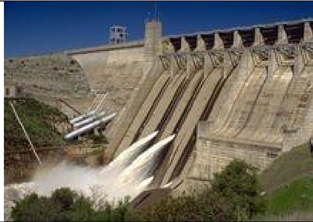
Abb. 7: Folsom Talsperre Zwischenauslässe (USBR 2004)
