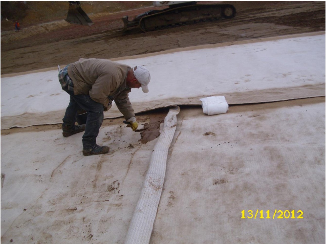
Abb. 6: Ausbildung eines Querstoßes an der Bentonitmatte (Foto Hagenloch)
