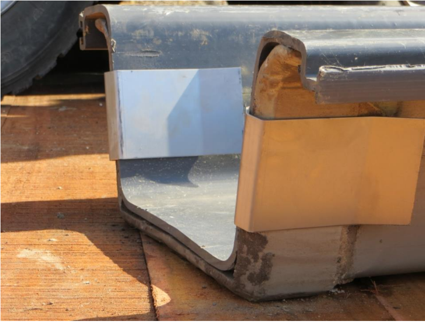
Abb. 3: Mitlaufende Mutterbohle und Stahlklammern
