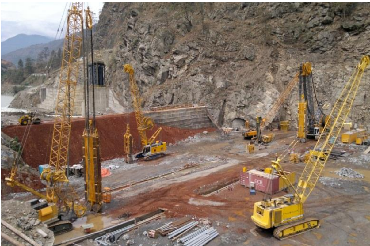
Abb. 5: Punatsangchhu-1 HEP – Herstellung der gefrästen Schlitzdichtwand
