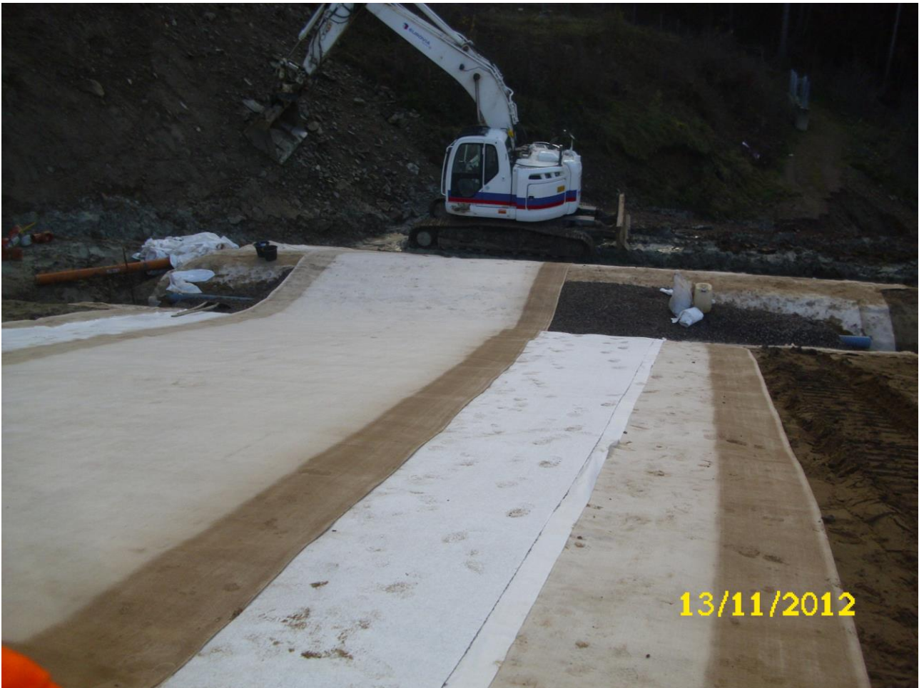
Abb. 4: Blick von oben auf die ersten verlegten Bentonit- und Dränmatten und unten die Rigole (Foto Hagenloch)
