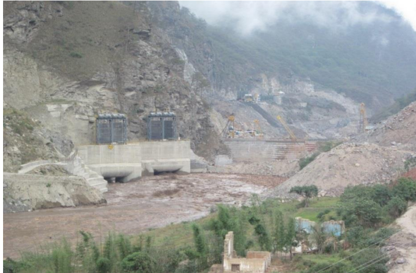
Abb. 3: Punatsangchhu-1 HEP: Einlaufbauwerk und Oberer Kofferdamm, Bauzustand
