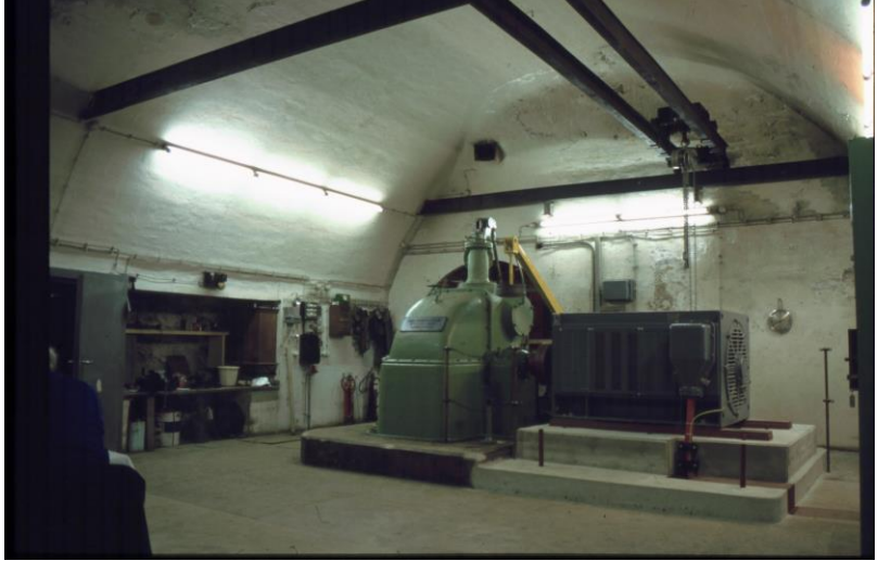
Abb. 18: Kavernenkraftwerk „Grüner Hirsch“, St. Andreasberg.
