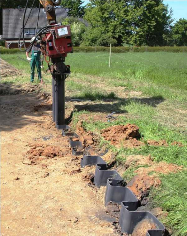
Abb. 8: partieller Bodenaustausch mit Kunststoffspundwand (Quelle EWE Netz GmbH)
