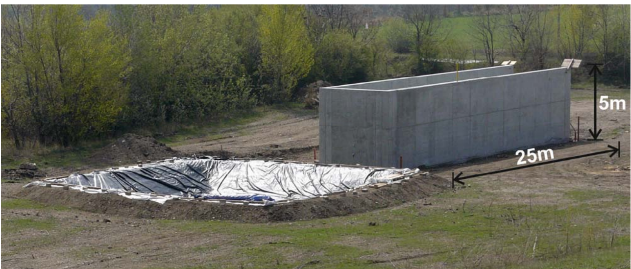
Abb. 12: Die Großversuchsanlage (Länge 25 m, Höhe 5 m und Breite 4 m) für die Versuche zur Unterströmung von Dämmen. Maßstab 1:1.
