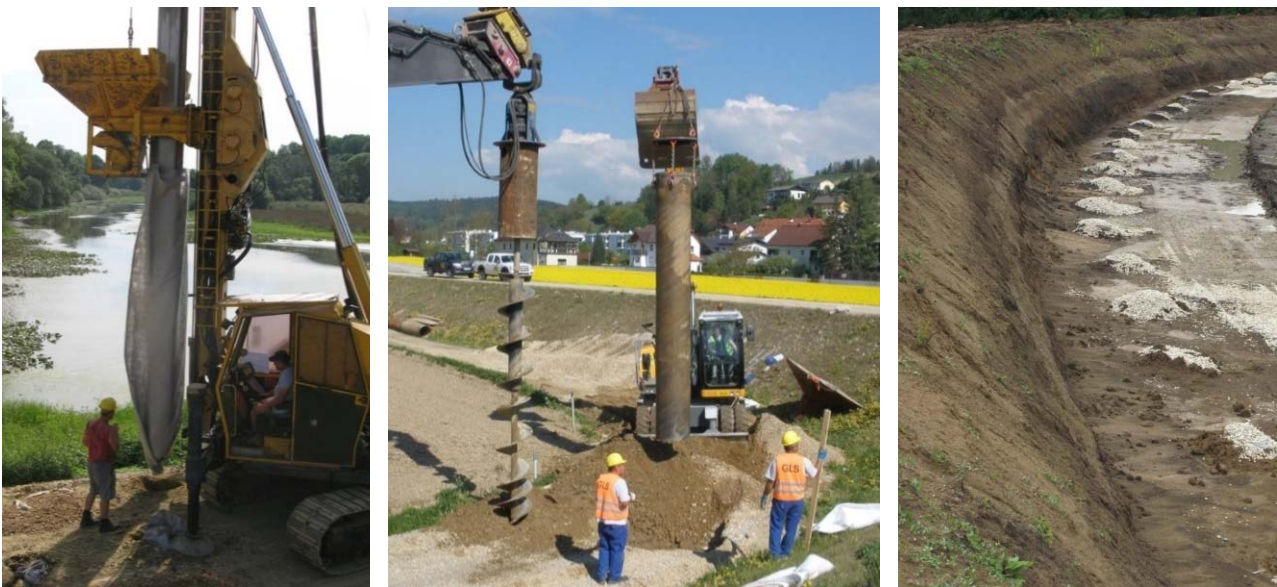
Abb. 10: Herstellung von Kiessäulen („Kiespfähle“) mittels Rüttelstopfverdichtung (links) und verrohrter Drehbohrung (Mitte); fertige Säulen (rechts).
