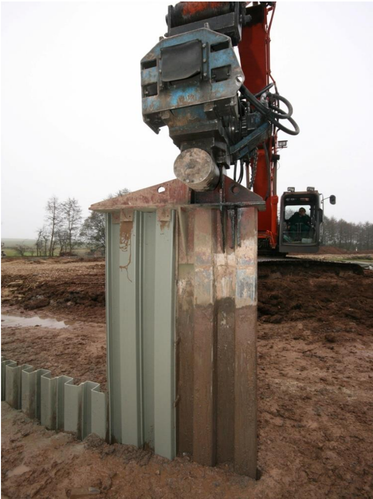
Abb. 2: Kunststoffbohle mit vorlaufender Mutterbohle
