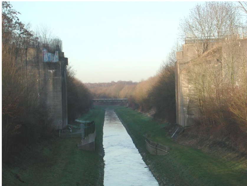
Abb. 5: Emscher mit charakteristischem Doppeltrapezprofil und Blick auf die Engstelle „Damm-Zechenbahn“ (s. Abb. 6, rechts) im Untersuchungsgebiet
