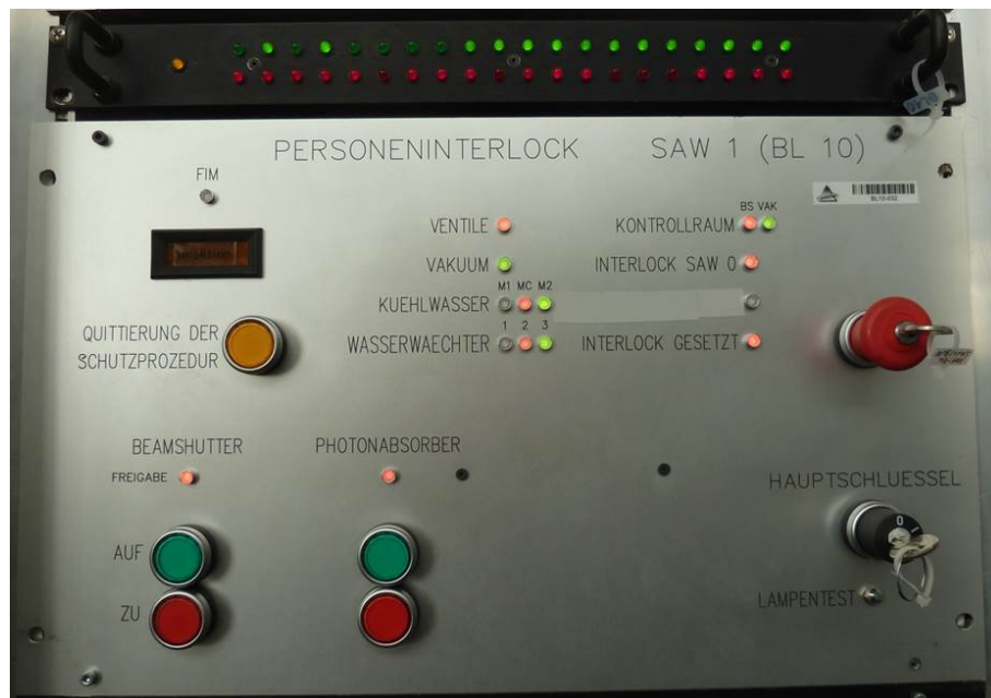
Abbildung 3.18: Frontplatte zur Steuerung des Personeninterlocks der Strahllinie BL 10 und Hauptrelaiskarte (oben).
