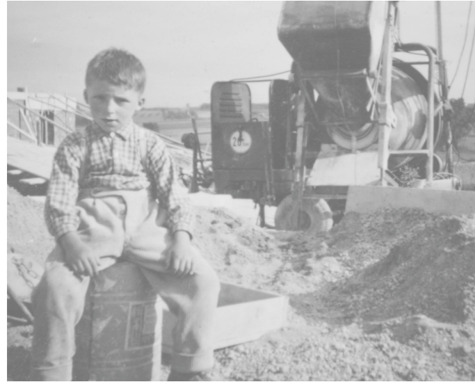
Baustelle in Schwaben
