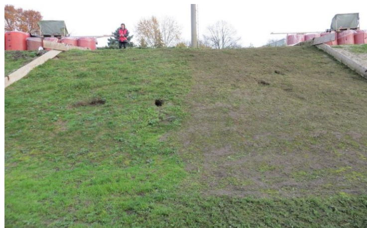
Abb. 3: Impression des Forschungsdeiches in Biebesheim (ca. 10 m breite Überströmstrecke mit unterschiedlicher Maht)
