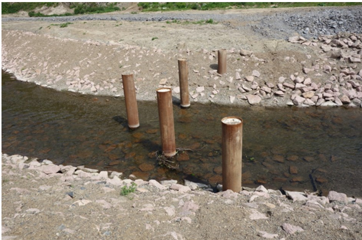
Abb. 1: V-Rechen als Treibgutfang (Quelle: Eiden, 2016)
