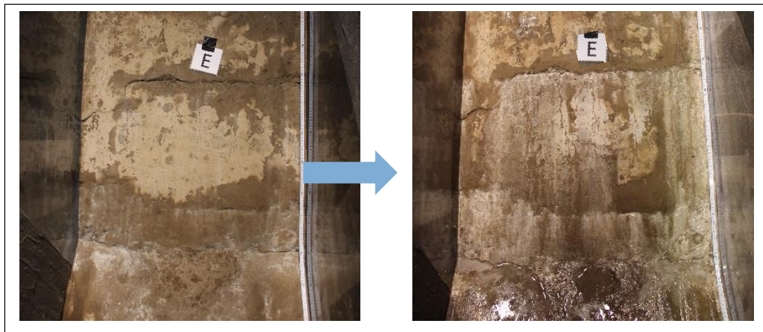
Abb. 2: Detailansicht der Böschung nach 1.1 (links) und 3.3 (rechts)
