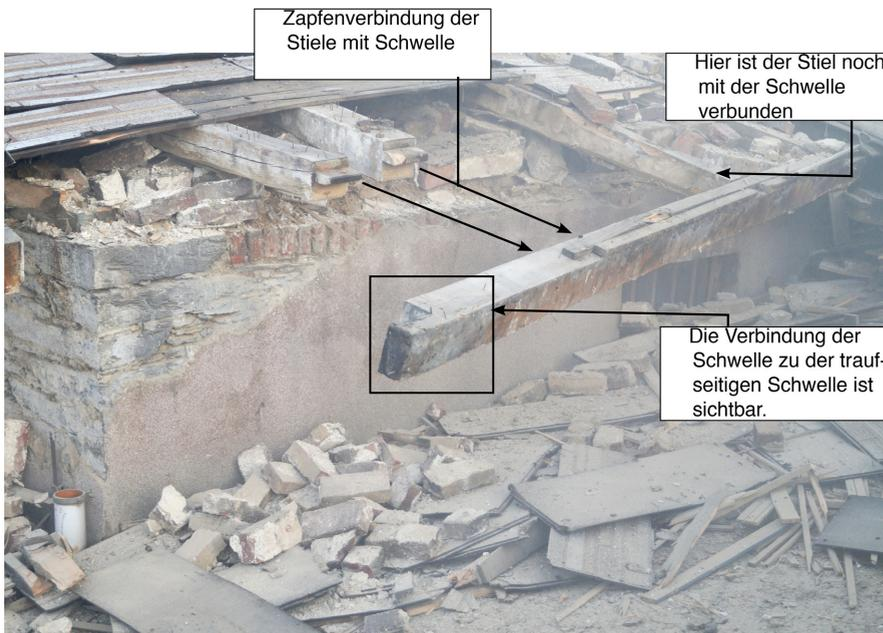
22 Erdgeschoss Ecke Süd-West - Schwellenverbindungen und Zapfenverbindungen.
