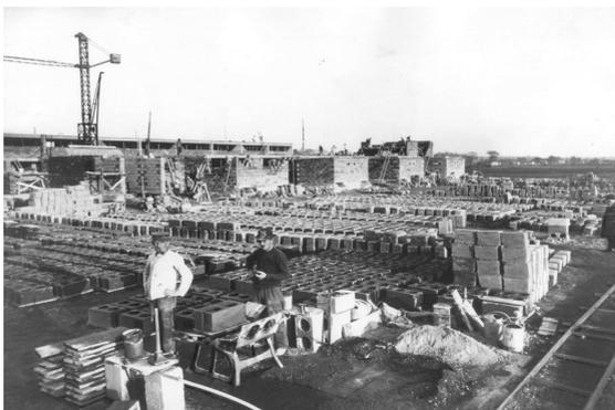
7 Baustelle des ersten Bauabschnitts, Fertigung der Schlackenbetonsteine in den späteren Gärten, Aufnahme 1927 (Bauhaus-Archiv Berlin).
