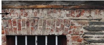
**25 und 26** Zeichnung einer Rollschicht. Zeichnung: Heinrich Gamann, Tafel I Fig. 11 (links) Rollschicht über KG Mauerwerk, unter Schwelle EG, Maccostaße 9 (rechts) Fotografie: Ann-Christin Stolz, 03.12.2016
