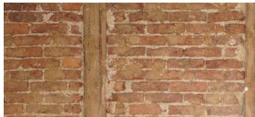
**23 und 24** Läufer-schicht im Verband gemauert. Zeichnung: Heinrich Gamann, Tafel I (links) Ausfächerung der Konstruktion - Tonziegelsteine in Läufer-schicht im Verband gemauert, Maccostaße 9 (rechts) Fotografie: Ann-Christin Stolz, 03.12.2016
