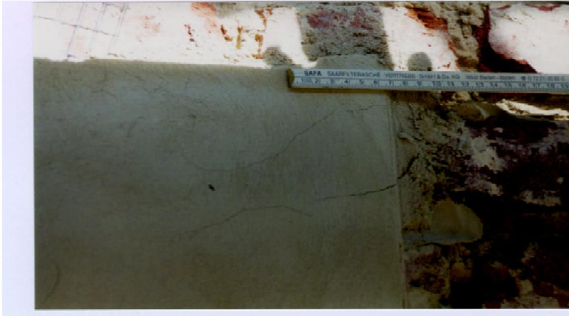
Abbildung 10: Rißbildung parallel zu einer Fuge in einer Musterfläche an der Wand der Parochialkirche
