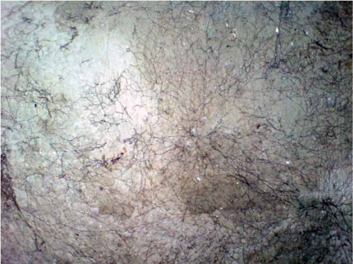
Abbildung 3-104 - Brauner Kellerschwamm
