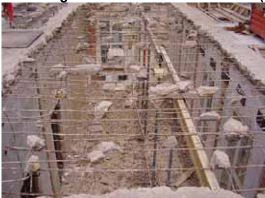
Abbildung 5-117 - Entfernen einer Decke (Q.: Anderhalten Architekten)
