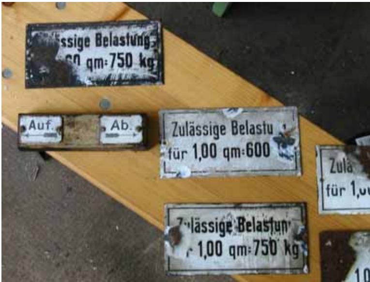
Abbildung 3-93 - Schilder mit Angabe zulässiger Belastungen in der "Neuen Schlosserei" der Amalienhütte
