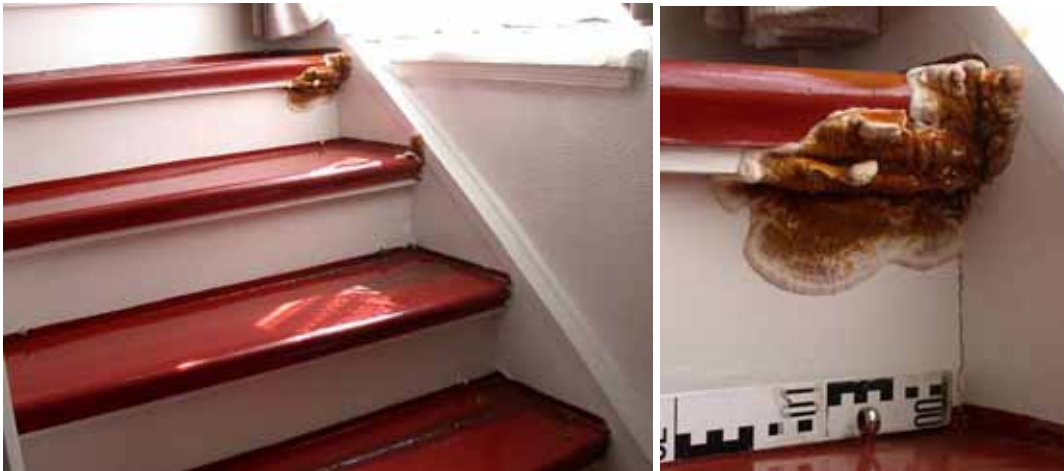
Abbildung 3-248 - Die Treppe durchdringender Fruchtkörper Abbildung 3-249 - Nahaufnahme
