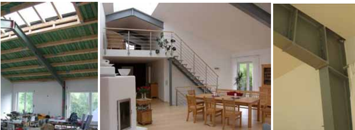
Abbildung 4-22 - Dachkonstruktion während der Bauphase Abbildung 4-23 - Innenraum (Essbereich) nach Umbau Abbildung 4-24 - Rahmenecke
