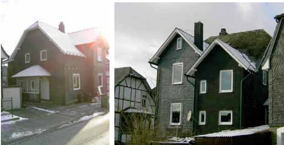
Abbildung 3-85 - Straßenansicht Abbildung 3-86 - Rückansicht
