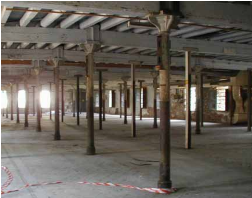
Abbildung 3-127 (oben) - Gussstützen Tuchfabrik Radevormwald Abbildung 3-128 (rechts) -Gussstützen (Fuß1853) (Q.: Ahnert/Krause2002 S.22/27)
