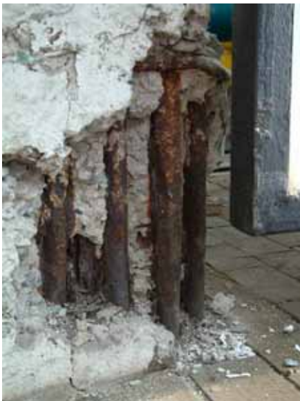
Abbildung 3-122 - Stützenfuß "Mechanischen Werkstatt" der Charlottenhütte, Niederschelden
