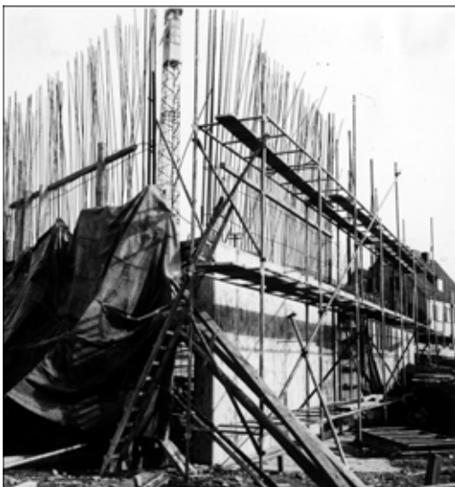
Abbildung 3-229 - Betonierarbeiten UG (Q.: Ev. Kirchengemeinde Weidenau)
