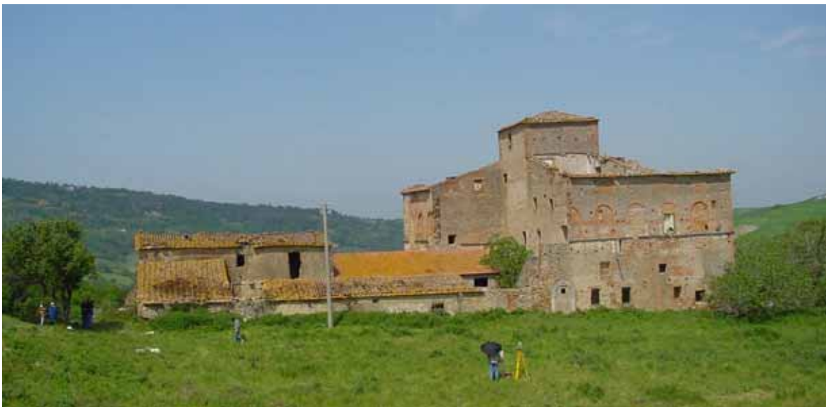
Abbildung 3-19 - Ostfassade der Villa la Rocca
