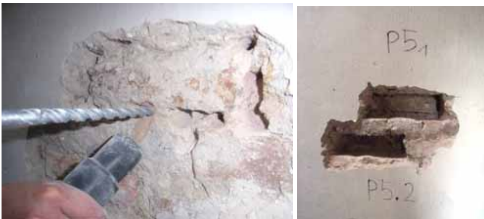
Abbildung 3-209 - Entnahme ganzer Mauerziegel
