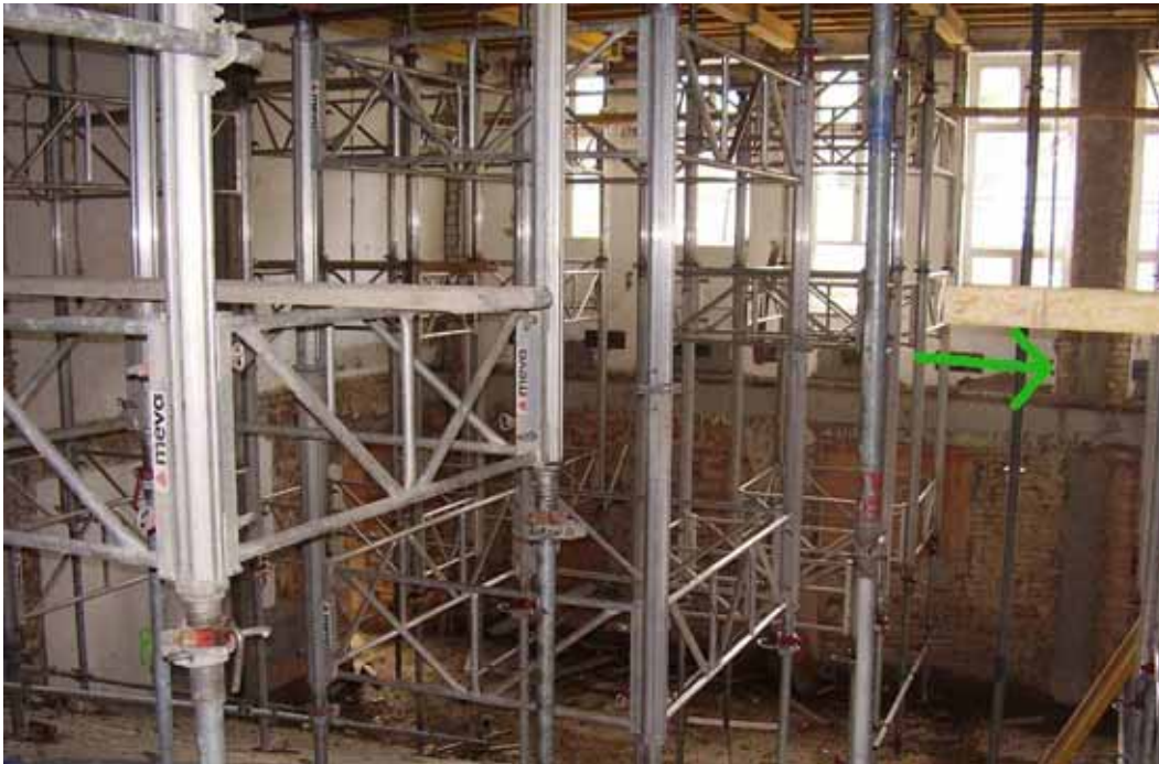
Abbildung 5-122 -Ausgeschalte Stahlbetonstütze(Pfeil) (Q.: Anderhalten Architekten)
