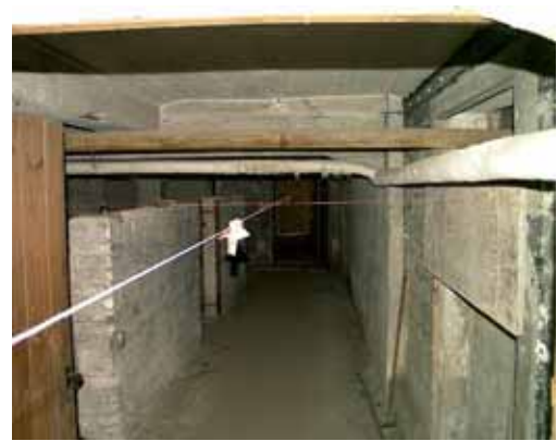
Abbildung 3-34 - Diagonalenmessung mit Laserdistanzmessgerät
