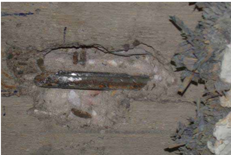
Abbildung 3-240 - Freigelegte Bewehrung
