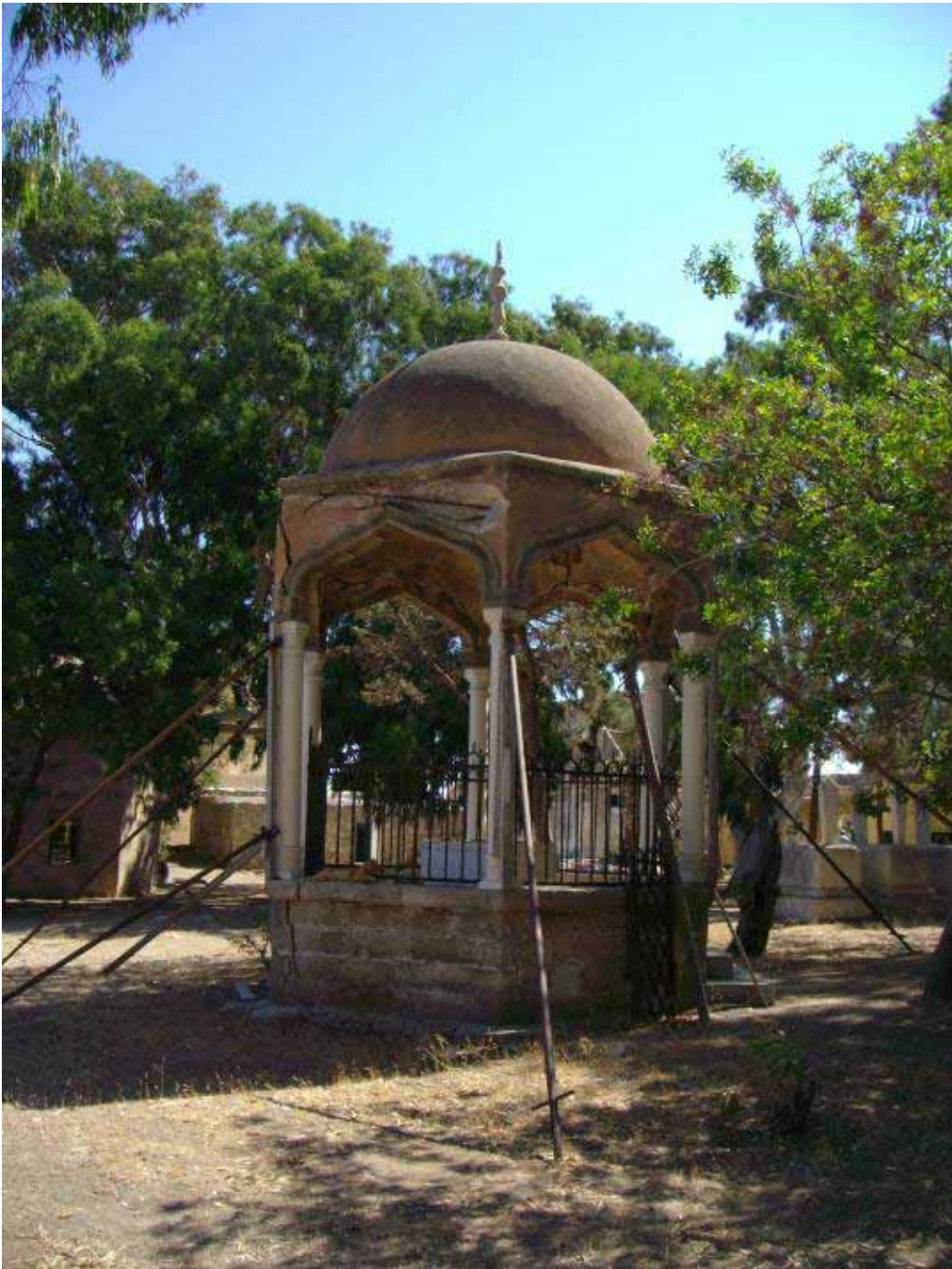
Abbildung 5-1 - „Ertüchtigter“ Pavillon einer Friedhofsanlage auf Rhodos (Q.: M. Morkramer)
