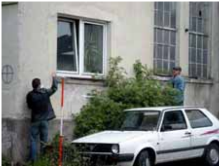
Abbildung 3-31 – Fassadenaufmaß mit Bandmaß
