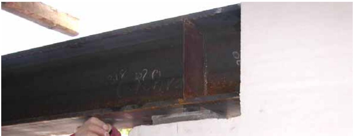
Abbildung 5-139 - Träger wird auf Stahlplatte gelagert
