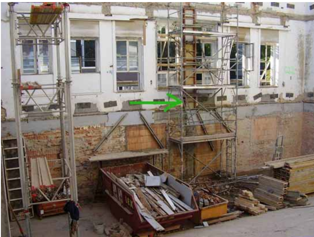
Abbildung 5-121 - Betonieren einer Stahlbetonstütze (Pfeil) zur Ertüchtigung der Mauerwerkswand (Q.: Anderhalten Architekten)
