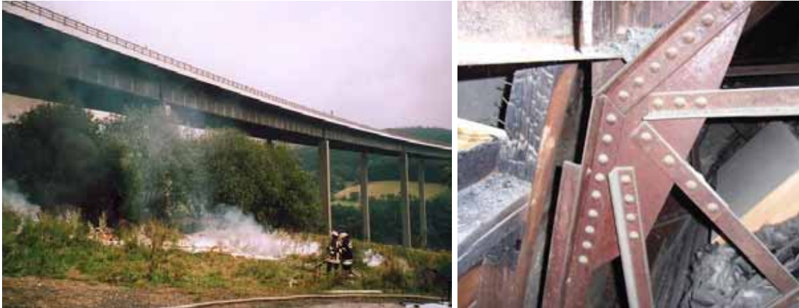
Abbildung 3-131 Wiehltalbrücke (Q.: http://de.structurae.de/photos/index.cfm?JS=25673 , C. Buschorn , 29.10.2007)
