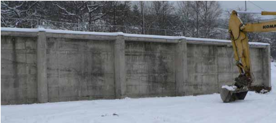
Abbildung 4-123 - Stützwall mit Betonfeilern
