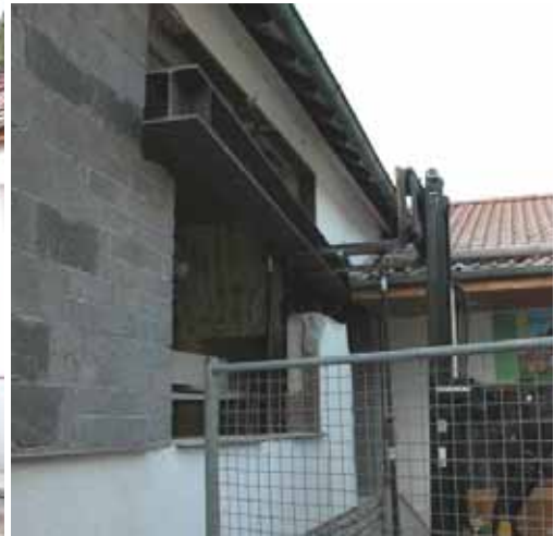
Abbildung 5-138 - Auflager aus Steinen der Festigkeitsklasse 20
