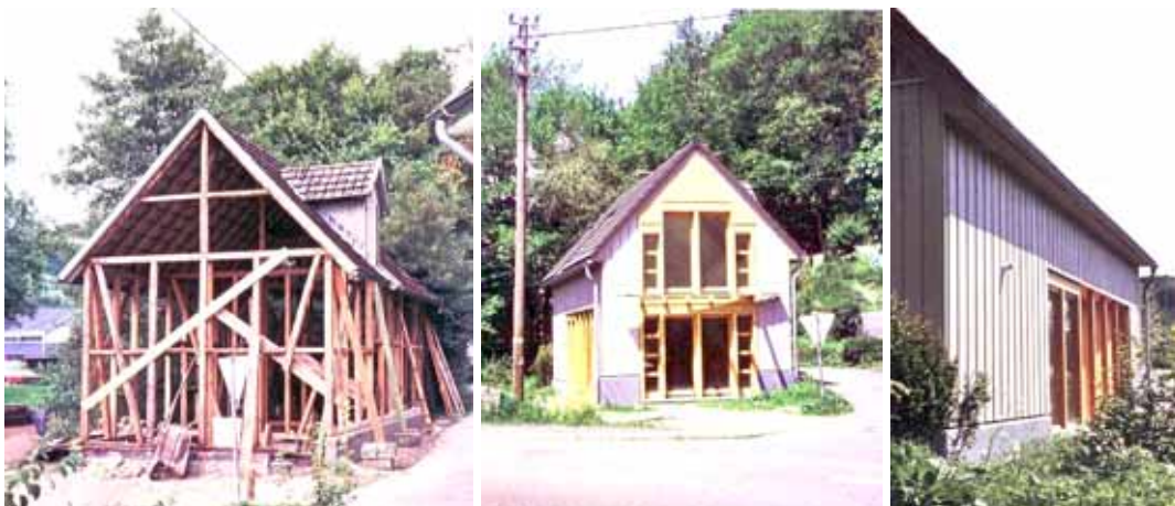
Abbildung 4-11 - Abgestützte Scheune in der Bauphase
