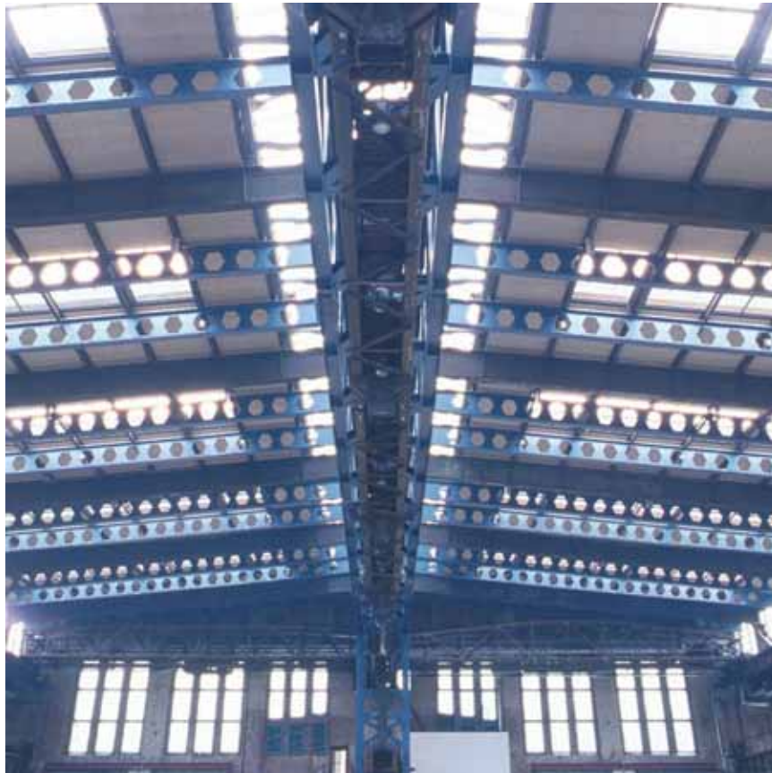
Abbildung 5-170 - Fertiggestellte Halle (Q.: http://www.hempel-ingenieure.com/images/minibilder/2_INT-Sicherung/G05_Lokhalle-Fertig.jpg , 16.01.2008)
