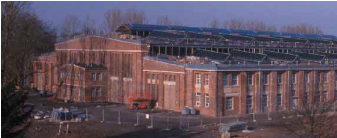
Abbildung 5-167 - Ansicht der Lokhalle (Q.: http://www.hempel-ingenieure.com/images/pdfs/2_Sicherung-Sanierung/G05_Lokhalle-Goettingen_2000.pdf , 16.01.2008)
