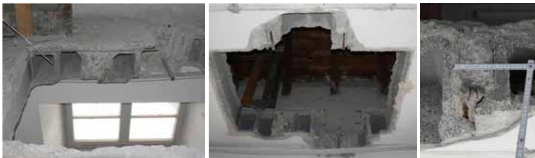
Abbildung 3-195 - Deckenöffnung zum DG (Oberseite)
