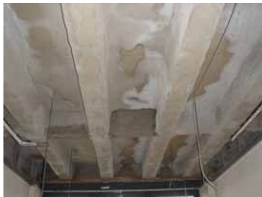
Abbildung 5-9 - Sanierung mit Spritzbeton (vorher) (Q.: Jockwer & Partner, Berlin)
