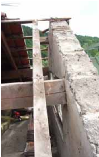
Abbildung 5-131 - Öffnen des Daches Abbildung 5-132 - Eingebauter HEB 180 Abbildung 5-133 - Abstützen einer Mittelpfette
