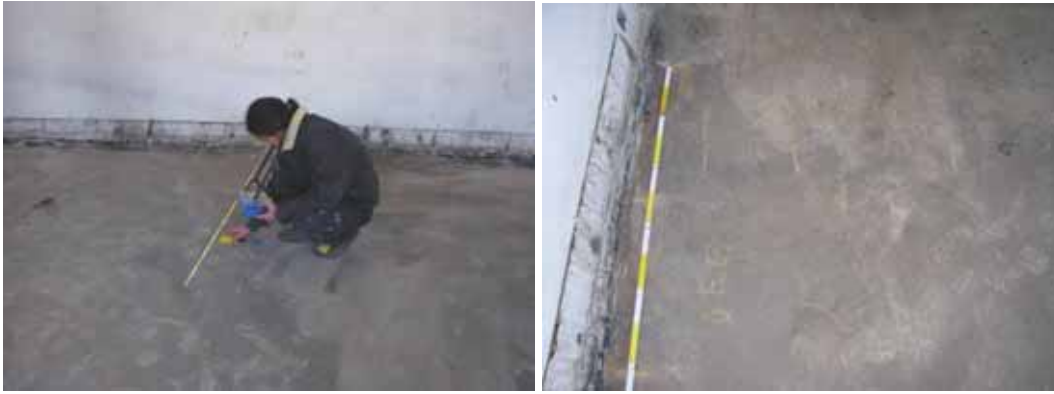
Abbildung 3-202 - Ermittlung der oberen Bewehrung mit Magnetwirbelstromverfahren Abbildung 3-203 - Sowohl obere Rippenbewehrung (orthogonal zu Zollstock) als auch Bewehrung in der Deckenplatte zur Lastverteilung (parallel Zollstock) konnte festgestellt werden.
