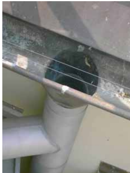
Abbildung 3-125 - Dachrinne und Falleitung Bodemuseum, Berlin 2006 Abbildung 3-126 - Anschlussdetail
