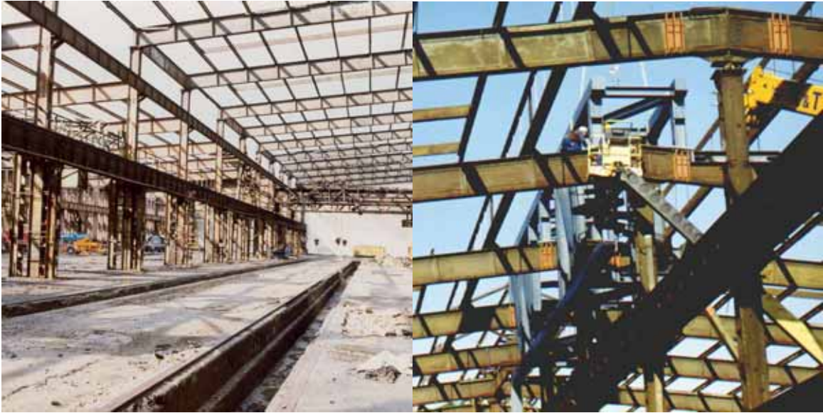
Abbildung 5-168 - Freigelegte Stahlträger (Q.: http://www.hempel-ingenieure.com/images/minibilder/2_INT-Sicherung/G05_bild12.jpg , 16.01.2008)
