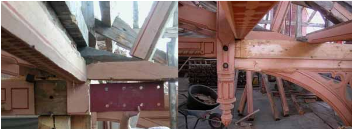
Abbildung 5-110 - Eingeschlitztes Blech für den Anschluss am Horizontalbalken
