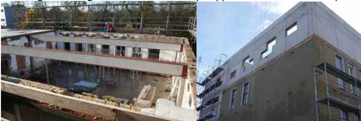
Abbildung 5-123 - Stahlverbundträger zur Aufnahme der neuen Decke über OG (Q.: Anderhalten Architekten)
