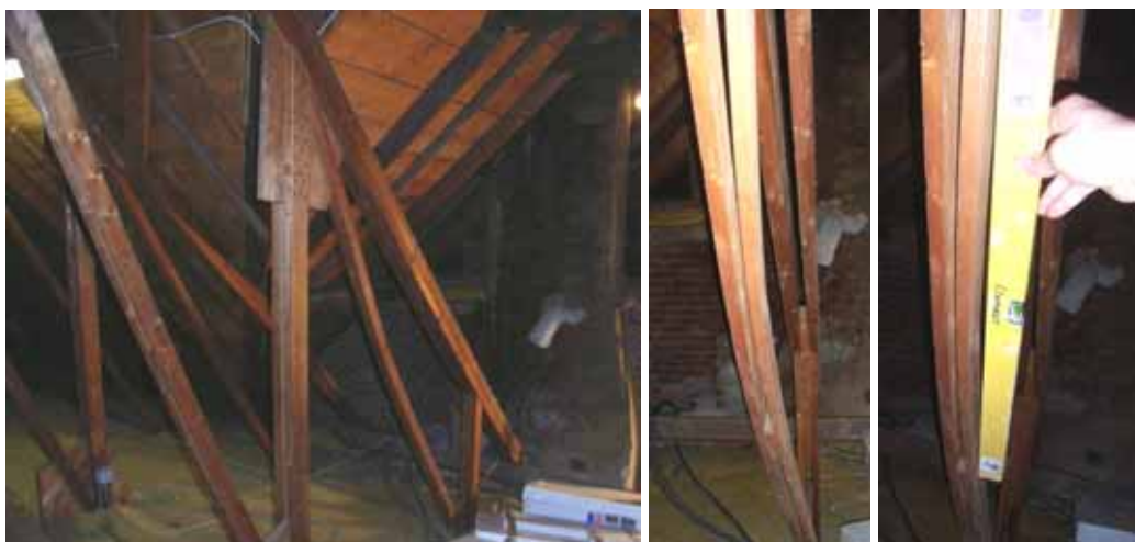
Abbildung 4-111 - Durchbiegung des Diagonalstabes unter dem Kehlsparren
