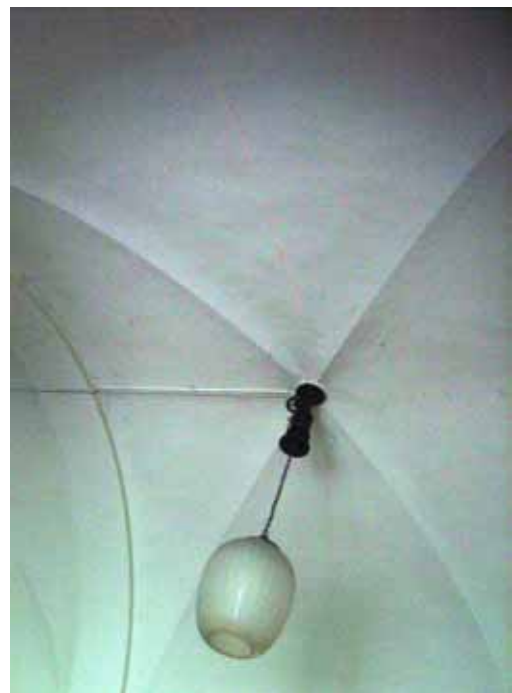
Abbildung 3-57 - Mit Rotationslaser markierte Schnittebene für Kellergeschossgrundriss... Abbildung 3-58 - ...und Gewölbeschnitt (Laser oben Mitte)
