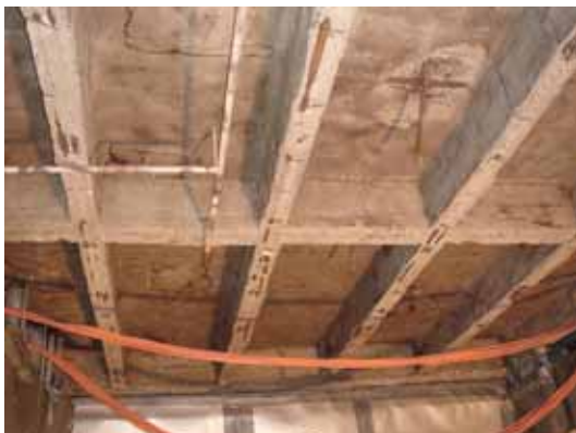
Abbildung 5-9 - Sanierung mit Spritzbeton (vorher) (Q.: Jockwer & Partner, Berlin)
