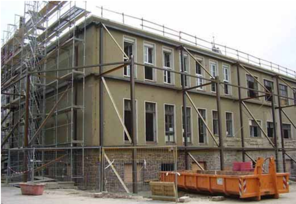
Abbildung 5-114 - Ehemaliges Laborgebäude (Q.: Anderhalten Architekten)
