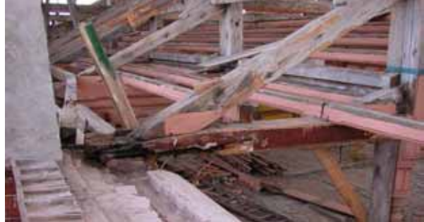
Abbildung 5-103 - Stark geschädigter Horizontalbalken zwischen Ertüchtigungsversuch aus U-Profilen (Q.: K. Block)
