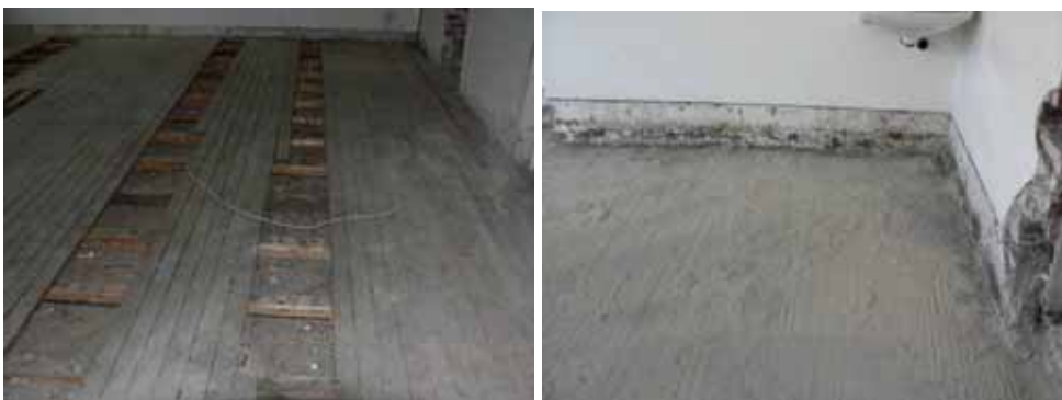
Abbildung 3-200 - Fußbodenaufbau (Dielen, Lagerhölzer und Schlacke)
