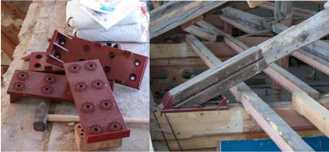
Abbildung 5-108 - Bestandteile der Stahlschuhe (Q.:K. Block)
