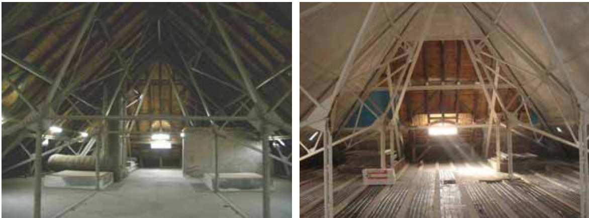
Abbildung 5-151 - Dachgeschoss vor der Maßnahme (Q.: Jockwer & Partner)
