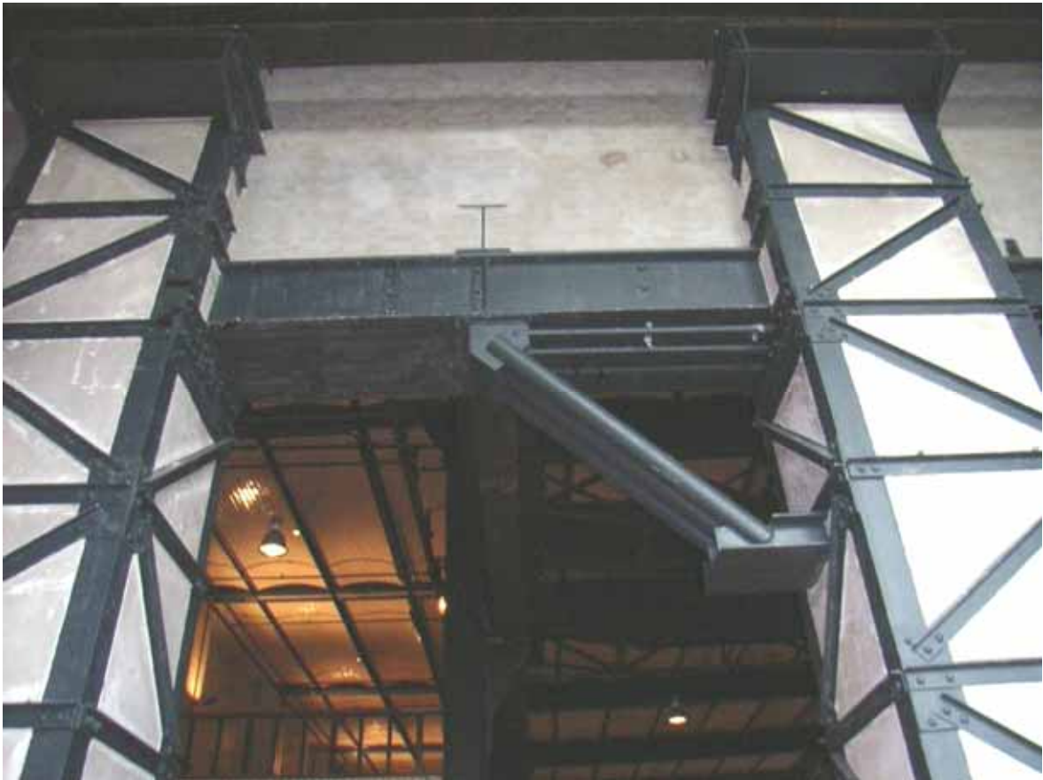
Abbildung 2-21 - E-Werk, Berlin-Mitte, Umbau: 2004/05 Arch.: Hoyer & Schindele
