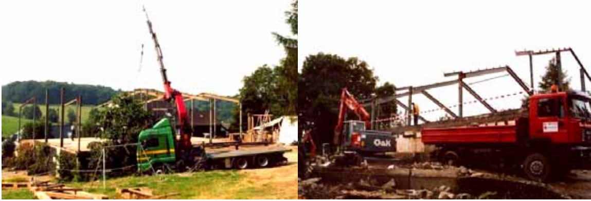
Abbildung 4-20 - Demontage der Stahlrahmen Abbildung 4-21 - Montierte leicht geänderte Rahmen
