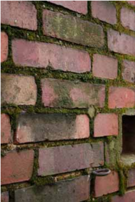
Abbildung 3-108 - Umspannwerk Uklei, Berlin
