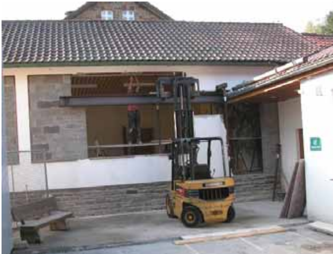
Abbildung 5-137 - Einbau des Trägers (HEB 280)
