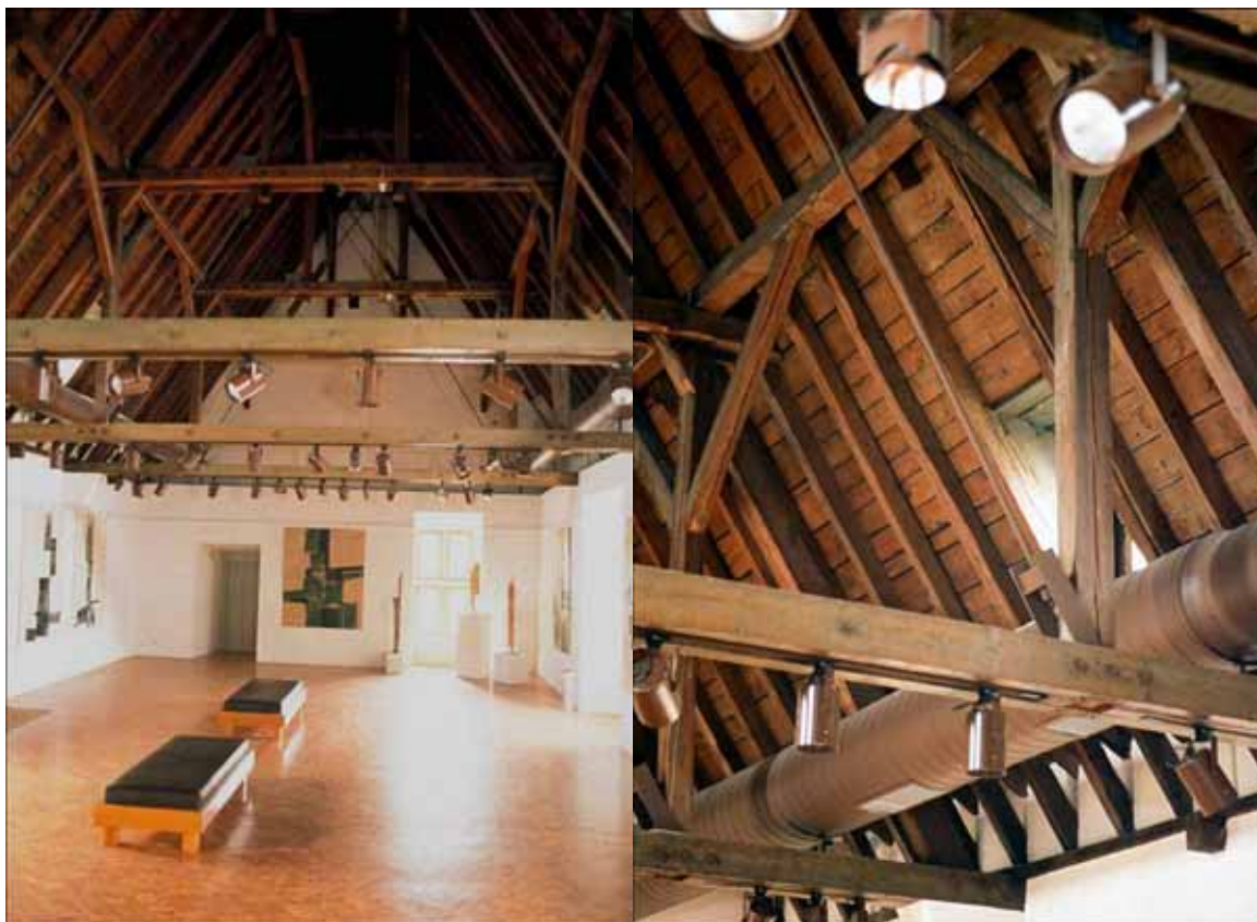
Abbildung 5-91 - Ausgeführter Dachstuhl (Q.: F. Stein) Abbildung 5-92 - Anschluss der Zugstange an vorhandenen Dachstuhl (Q.: F. Stein)
