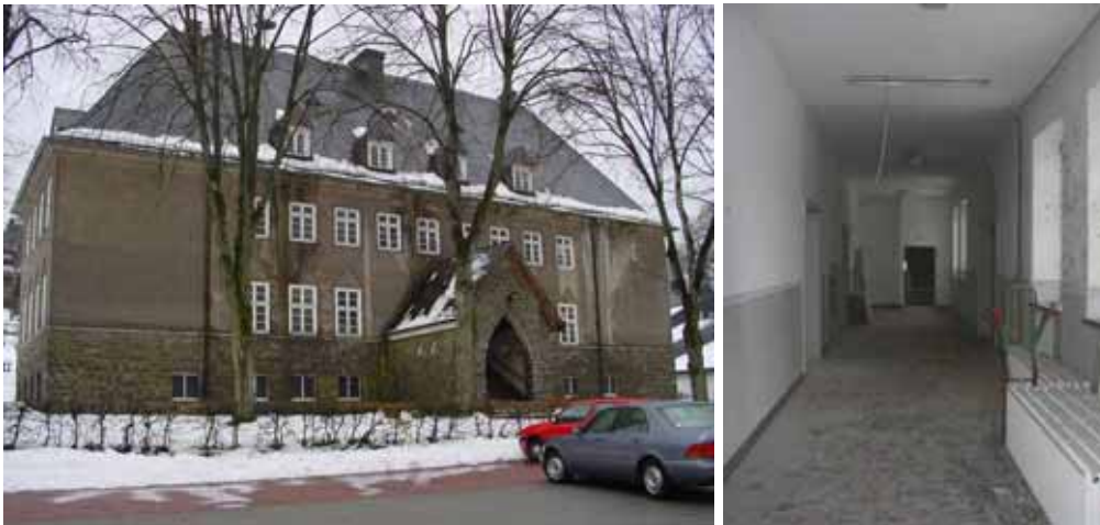
Abbildung 3-191 Ehemalige Schule in Wenden
