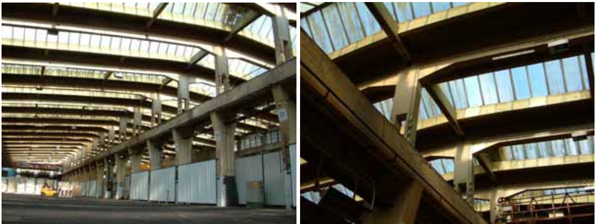
Abbildung 4-67 - Innenansichten der 150m langen Halle
