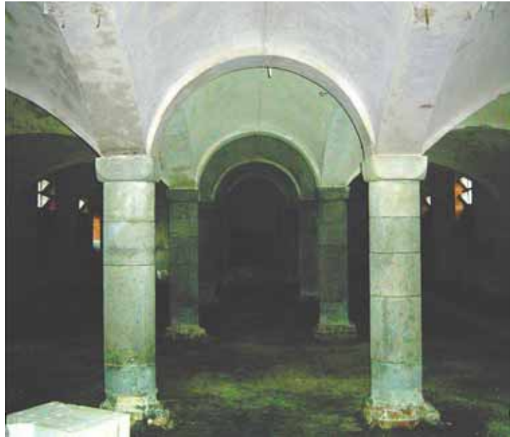
Abbildung 4-52 – Gemauerte Bogenkonstruktion Gutshof in Herborn
