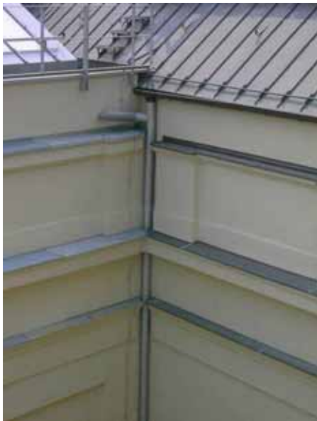
Abbildung 3-125 - Dachrinne und Falleitung Bodemuseum, Berlin 2006 Abbildung 3-126 - Anschlussdetail
