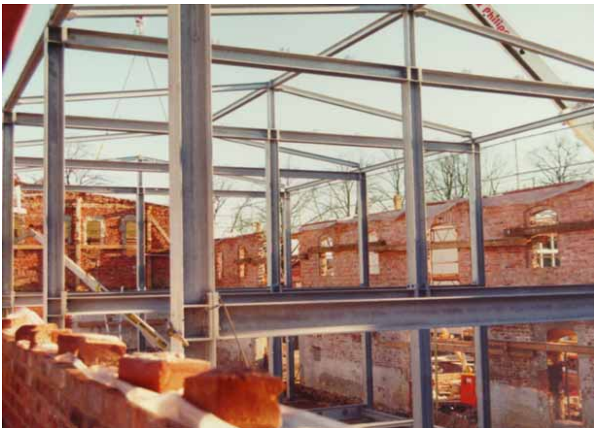
Abbildung 5-28 - Einbau der Neuen Stahlkonstruktion (Q.: C. Anderhalten)
