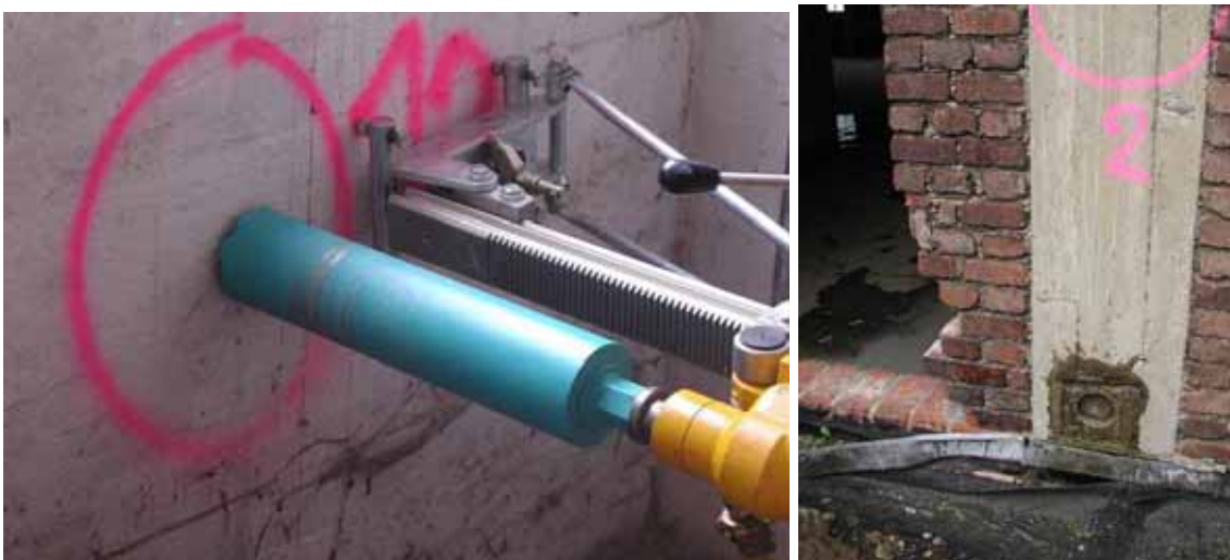
Abbildung 3-155 - Bohrkernentnahme (Nr.12) Wand EG
