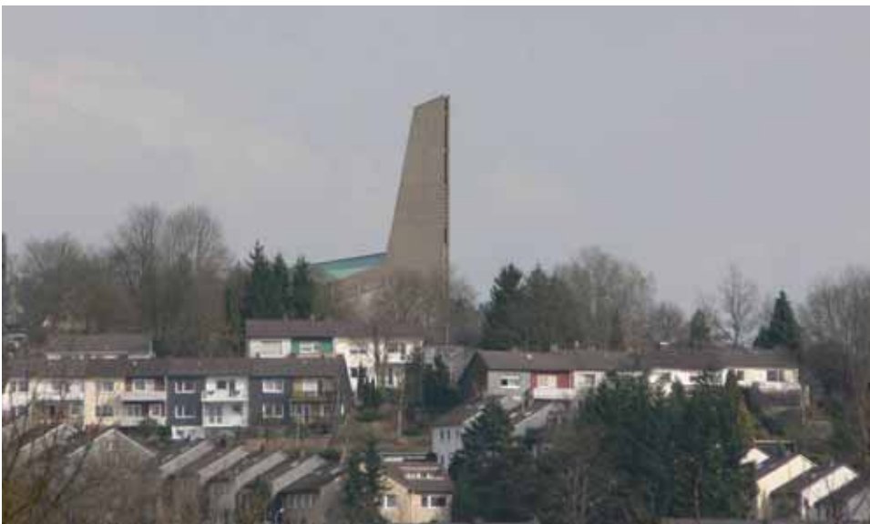
Abbildung 3-227 - Weithin sichtbare Christuskirche
