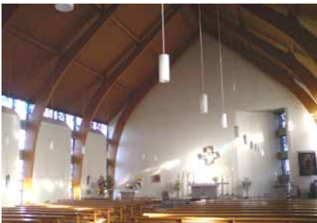
Abbildung 4-49 Kirchenschiff mit Dreigelenkrahen, Wissen-Schönstein
