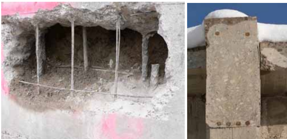
Abbildung 3-187 - Vertikale Stäbe im rückwertigen Bereich und vertikal angeordnete Matte im vorderen Bereich der Untersuchungsöffnung
