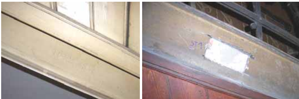
Abbildung 3-217 - Stahlträger Treppenwange zum DG Abbildung 3-218 - Entnahmestelle Stahlprobe 1
