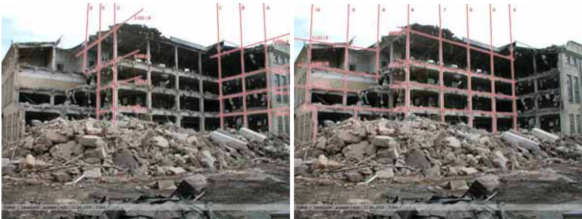
Abbildung 3-154 - Dokumentation der Abrissarbeiten
