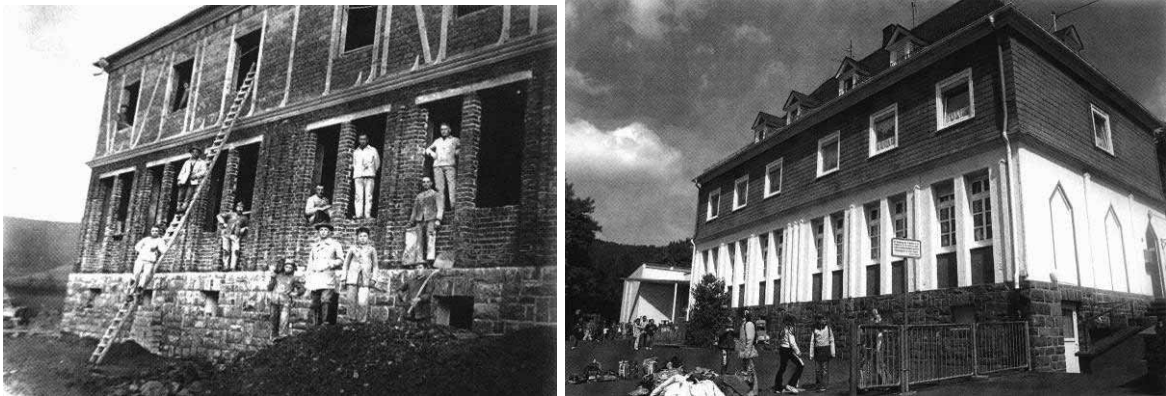
Abbildung 3-100 - Katholische Schule, Dreistiefenbach im Bauzustand... Abbildung 3-101 ...und in den 1990iger Jahren (Q.: F. Stein)
