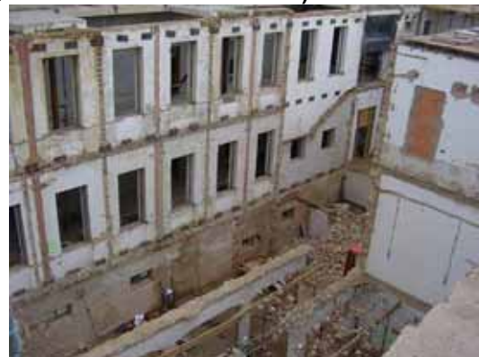
Abbildung 5-117 - Entfernen einer Decke (Q.: Anderhalten Architekten)
