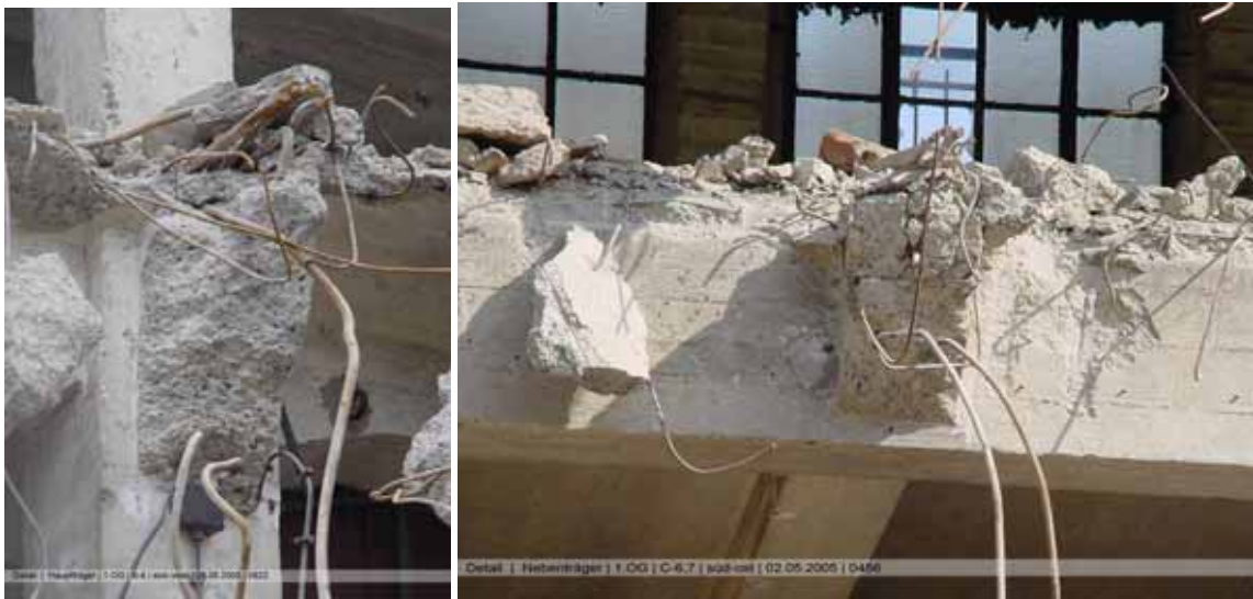
Abbildung 3-168 - Anschluss Hauptträger - Stütze Abbildung 3-169 - Anschluss Nebenträger – Hauptträger
