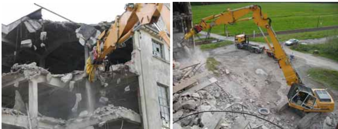
Abbildung 3-164 - Abrissarbeiten Abbildung 3-165 - Eingesetztes Gerät
