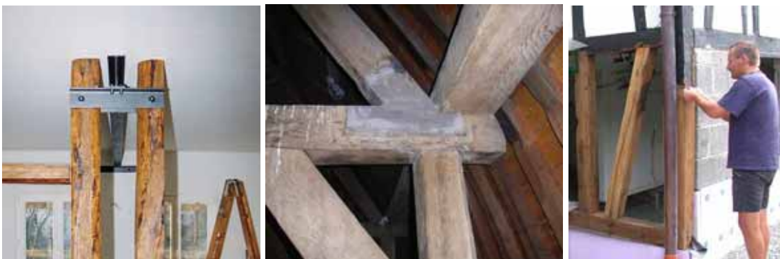
Abbildung 2-22 - Unterstützung einer Holzbalkendecke mit einem Stahlprofil
