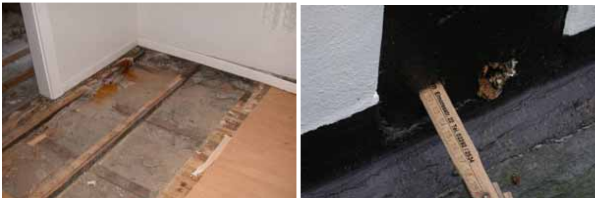
Abbildung 3-254 - Erneutes Öffnen der Fußbodenkonstruktion
