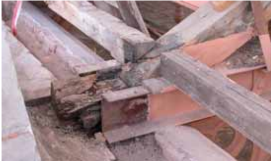
Abbildung 5-103 - Stark geschädigter Horizontalbalken zwischen Ertüchtigungsversuch aus U-Profilen (Q.: K. Block)
