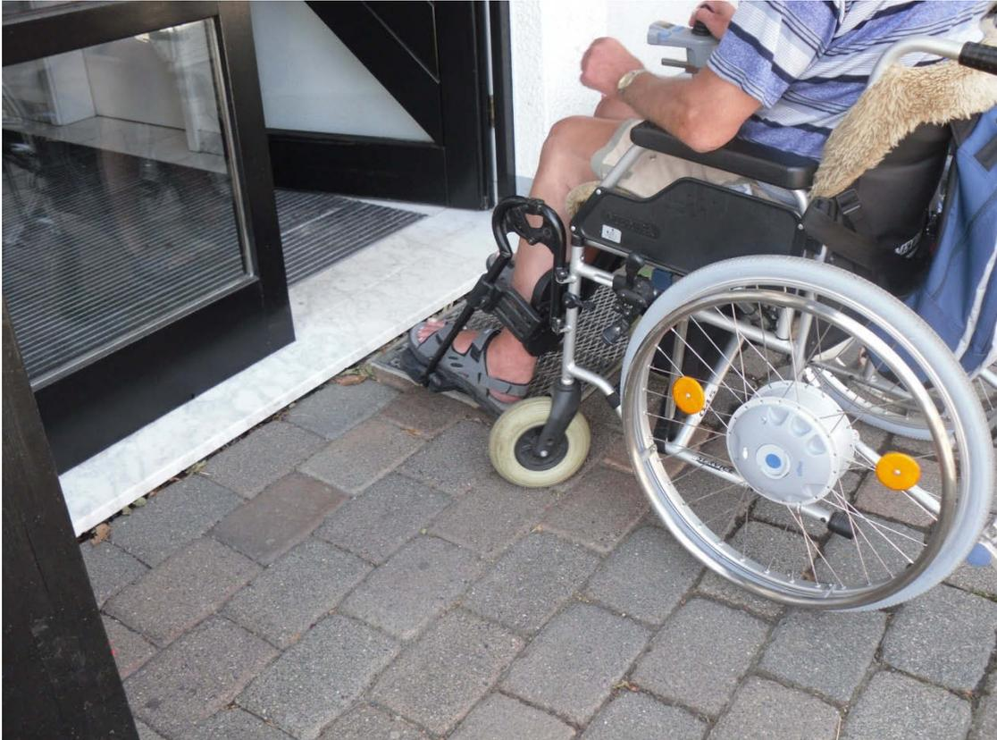
Stufe zum Eingangsbereich, Eingangsbereich sehr schmaler Flur, mit breitem Rollstuhl zu knapp, durch rillenartigen Bodenbelag gut zu erkennen
