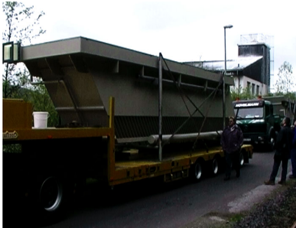
Bild 3.6: Anlieferung der Lamellenabscheider, Transport einer Einheit mit dem Kran
