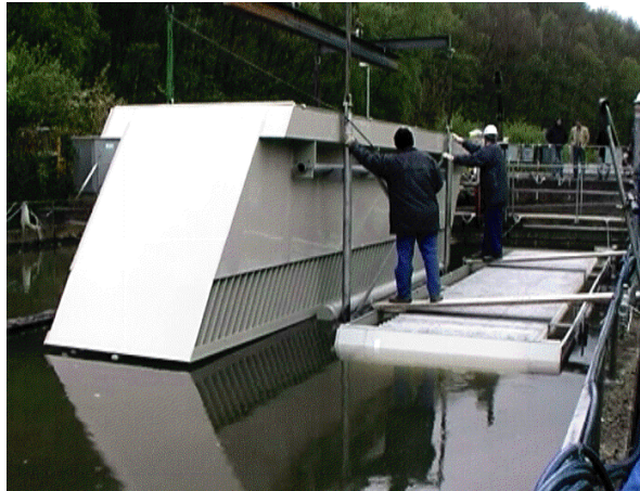
Bild 3.7: Installation der Lamellenabscheider im Belebungsbecken der Kläranlage Netphen
