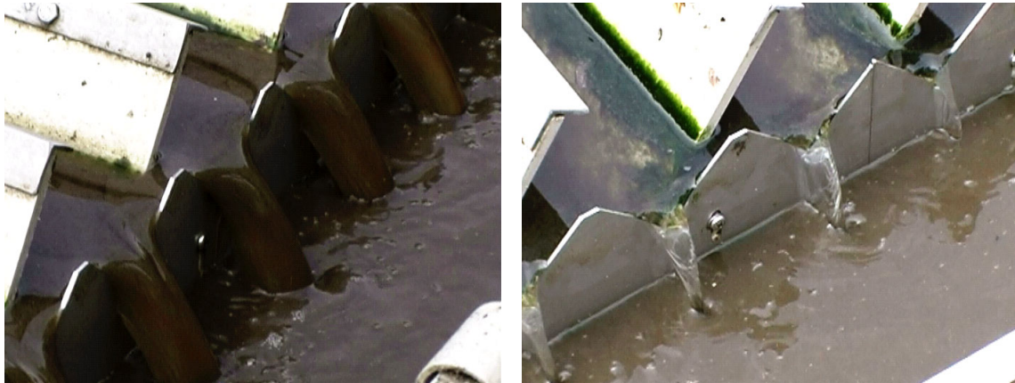
Bild 3.11: Unterschiede im Abscheidegrad (zeitgleiche Beobachtung an verschiedenen Stellen)
