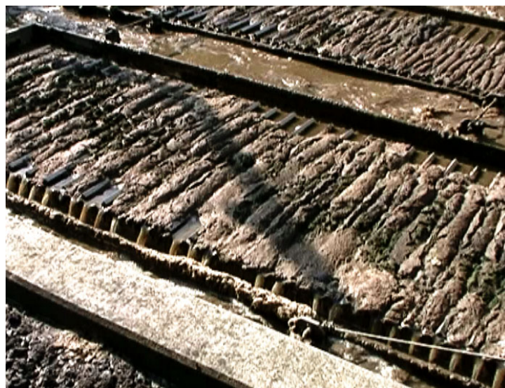
Bild 3.12: Schaumbildung auf den Lamellen (aus /Scön00b/)
