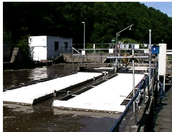
Bild 3.7: Installation der Lamellenabscheider im Belebungsbecken der Kläranlage Netphen
