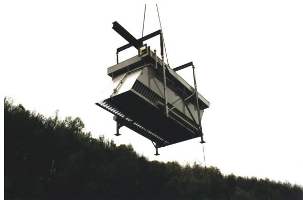
Bild 3.6: Anlieferung der Lamellenabscheider, Transport einer Einheit mit dem Kran
