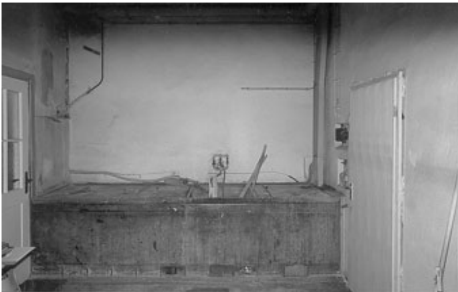
Abb. 12: Die Waschanlage vor ihrem Abbau 1987
