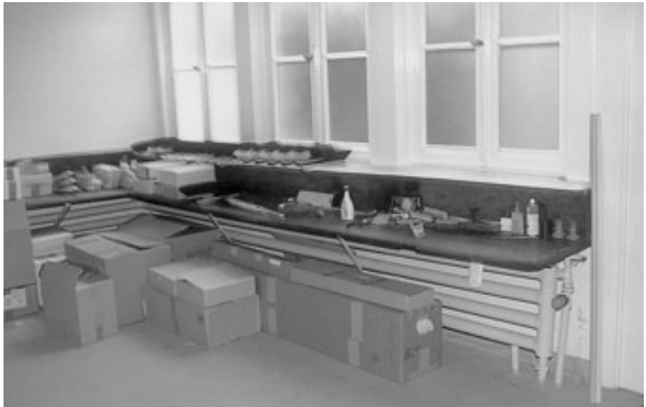
Abb. 9: Der Waschraum, Frühjahr 1994
