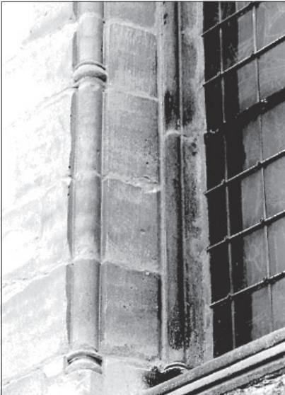
Abb.: 127: Rundstab mit Ringen an Fenstern und Nischen Quelle: Foto der Verf., 2002.
