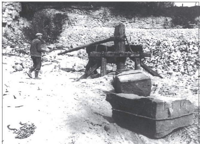
Abb. 91: Pferdewinde im Steinbruch Hesselmann Quelle: Eichler, Joachim (1993) S. 19
