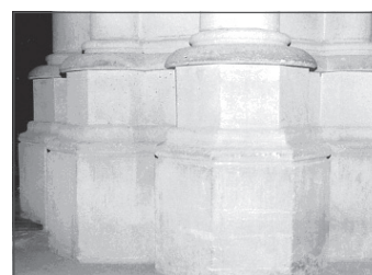
Abb. 106: Pfeilerfuß Quelle: Foto d. Verf. 2002.
