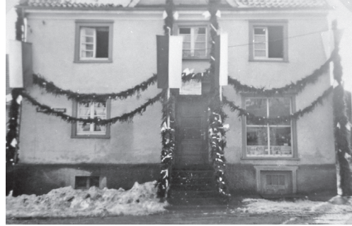
Abb. 22: Wohnhaus der Familie Steinbach nach 1945 mit Schaufenster für den Milchhandel rechts neben der Eingangstür. [Quelle: Privat].
