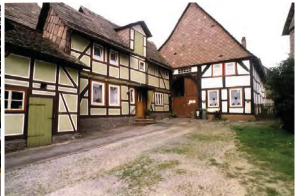
Abb. 3: Dreiständergebäude in Bevern, Am Markt 2.
