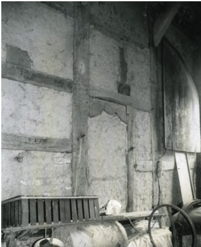
Bevern, Breslauer Str. 33, Zehntscheune, O-Dielenwand mit ehem. Türöffnung und Versprung in der Riegelkette
