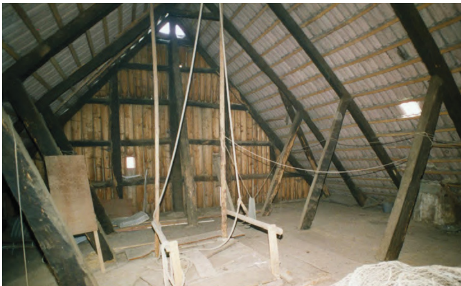
Derental, Lange Str. 8, Dach mit Sparrenstreben.
