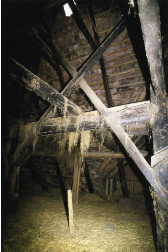
Bevern, Forster Str. 4, Spitzsäulendach, Wohnwirtschaftsgebäude von 1621
