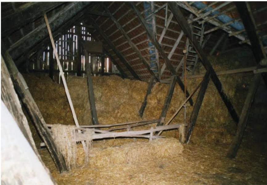
Derental, Lange Str. 12, Dachwerk mit Sparrenstreben im Kernbau
