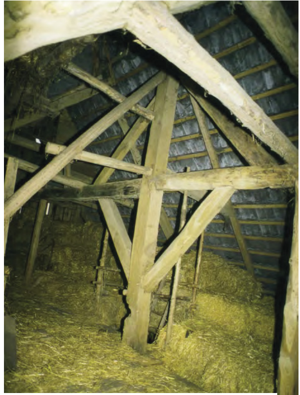
Bevern, Forster Str. 4, Spitzsäulendach, Scheune von 1735d
