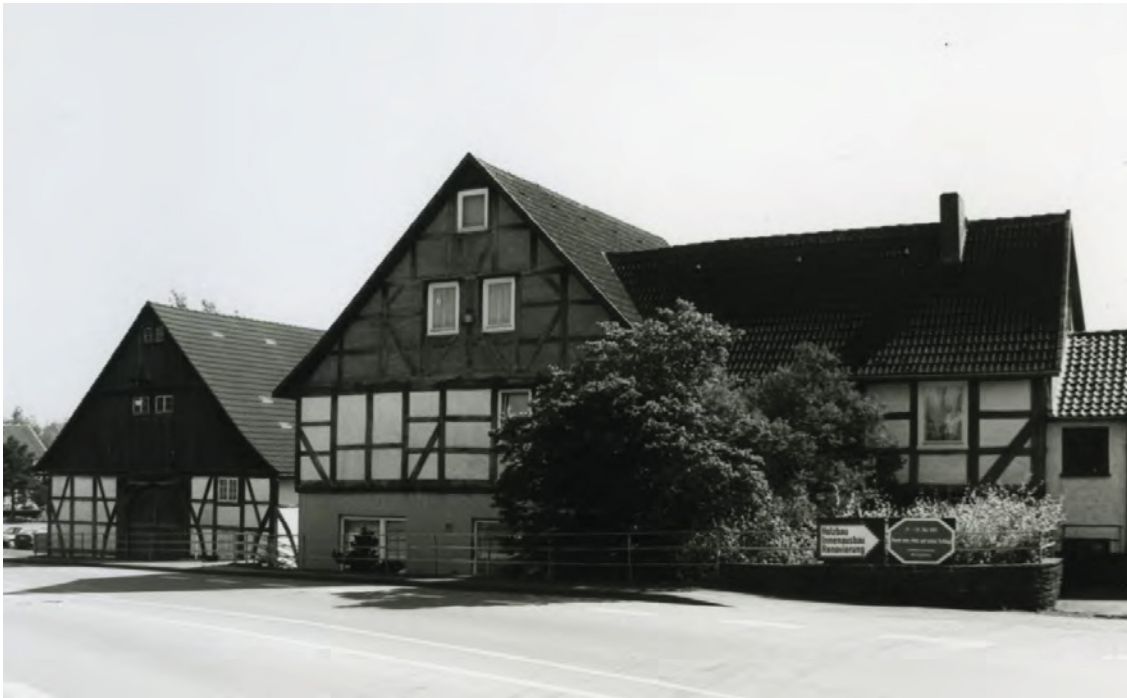
Scharfoldendorf, Luerdisser Str. 3, Wohnhaus von 1755 i, N-Giebel und traufseitiger Anbau.
