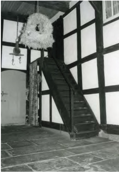
Abb. 39: Sandsteinplatten als typischer Bodenbelag der Diele, Bevern, Breslauer Str. 33.
