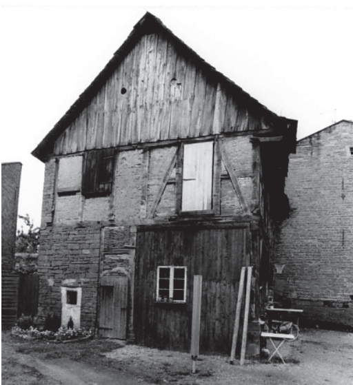
Bevern, Kaspul 16, Nebengebäude, NO-Giebel
