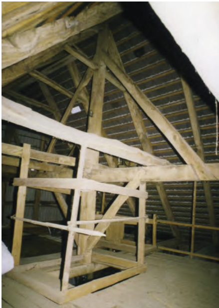
Negenborn, Winkel 23, Scheune, Dachwerk, mittige Spitzsäule von N
