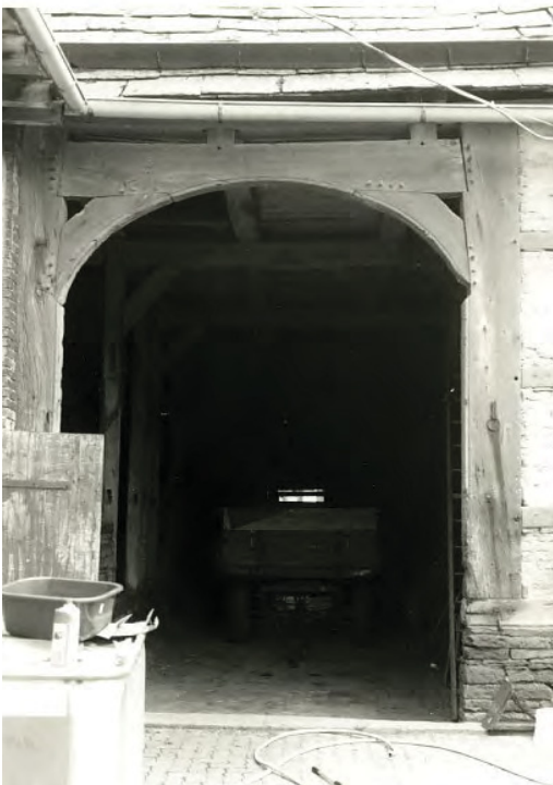
Bevern, Forster Str. 1, Dielentor von 1741 i, Querdielenscheune
