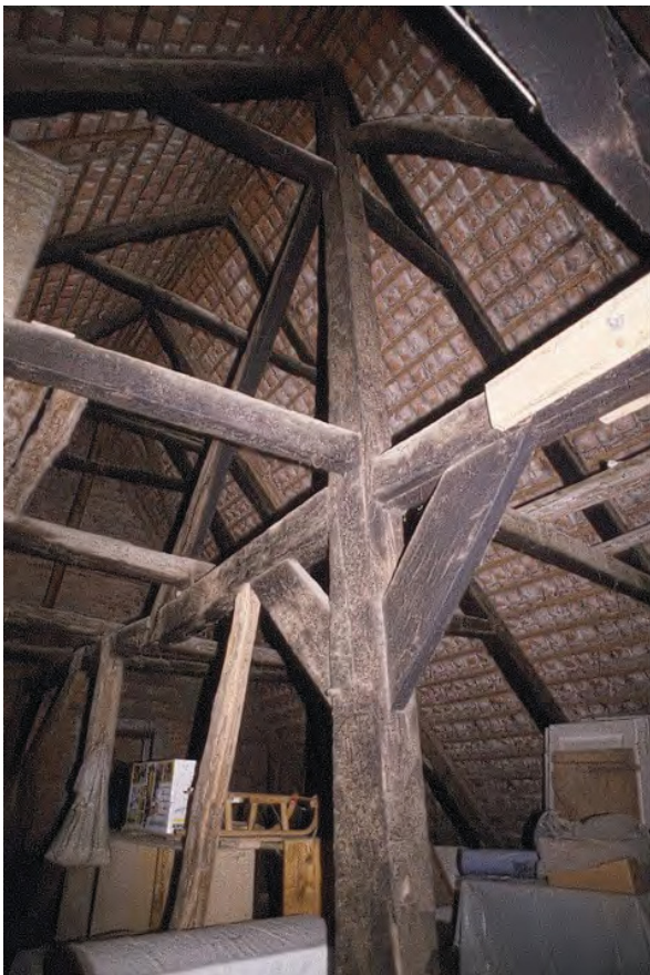
Scharfoldendorf, Am Kuhmarkt 3, mittlere Spitzsäule
