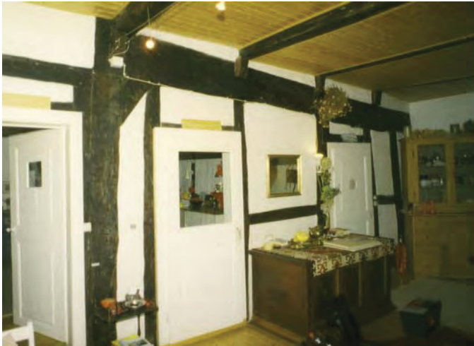
Abb. 34: Blick von der Diele auf den Luchtriegel, Polle, Doktorgasse 2.
