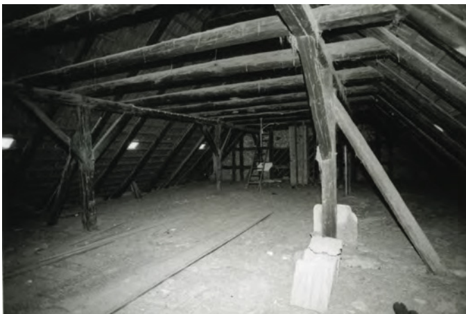
Scharfoldendorf, Tiefe Str. 6, Wohnwirt- schaftsgebäude, Dachwerk
