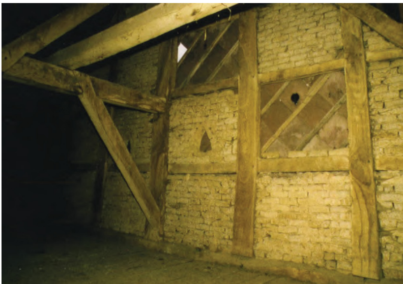
Negenborn, Winkel 23, Scheune, Vordergiebel mit Lehmputzenausfachung
