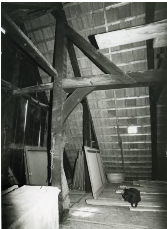
Heinsen, Hauptstr. 40, Spitzsäulendach, ehem. Giebelgebäude
