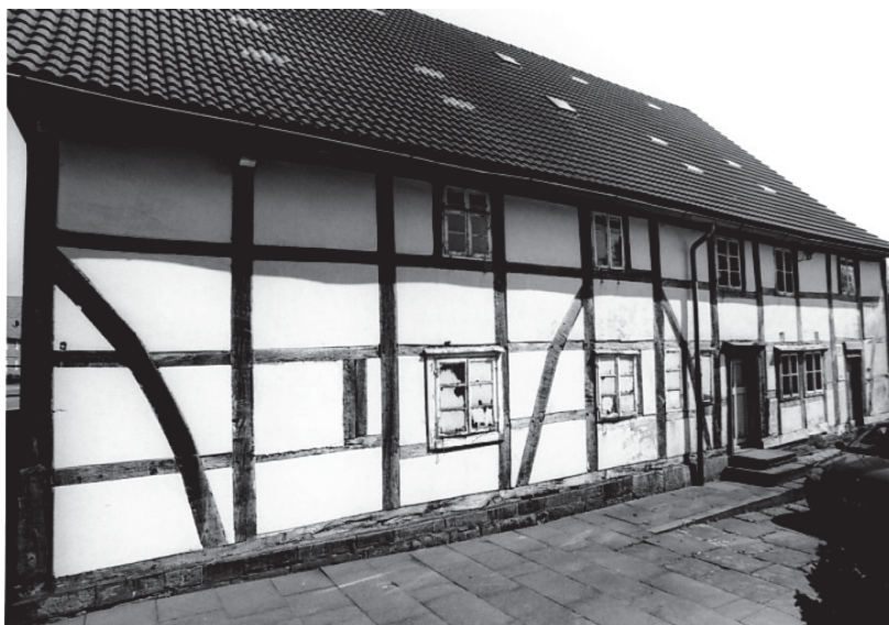
Scharfoldendorf, Luerdisser Str. 3, Vierständergebäude von 1795i, W-Traufe.
