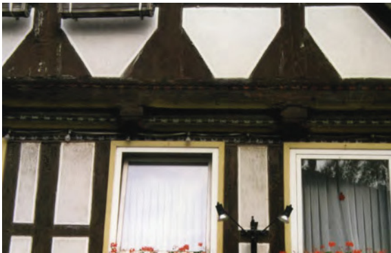
Bevern, Breslauer Str. 3, S-Giebel und Detail Vorkragung
