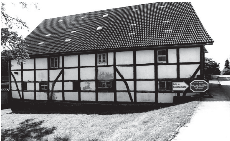
Scharfoldendorf, Luerdisser Str. 3, Vierständergebäude von 1795i, O-Traufe.
