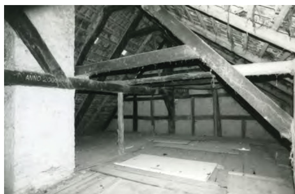
Eschershausen, Stadtbergstraße 18, Spitzsäulendachwerk von W
