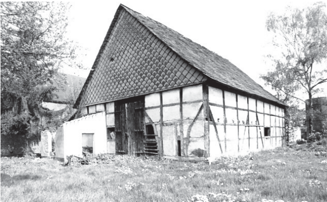
Scharfoldendorf, Mühlenstraße 2, Scheune, S-Giebel, 1. Bauphase.
