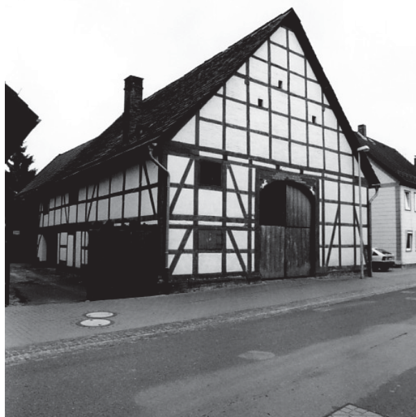
Warbsen, Forstbachtal 24, N-Giebel Scheune
