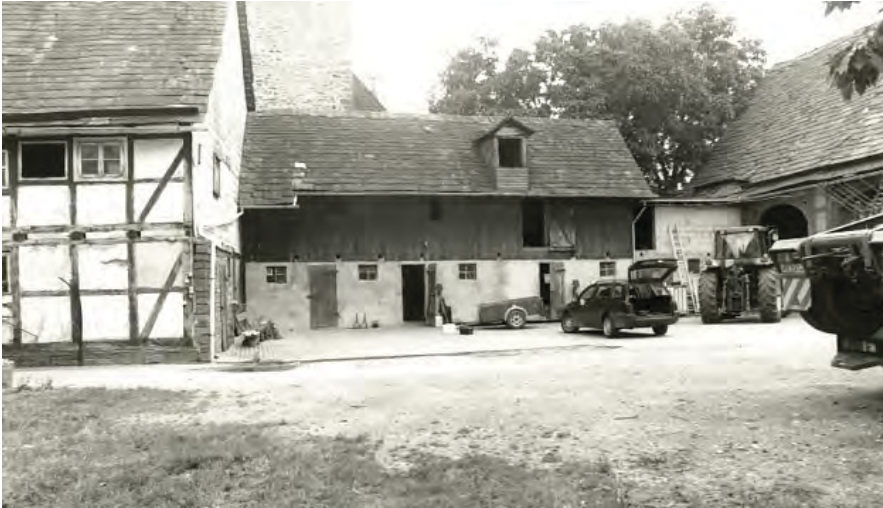
Bevern, Forster Str. 1, Stallanbau
