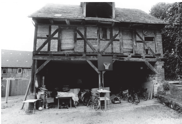
Bevern, Kaspul 16, Nebengebäude, NW-Taufe
