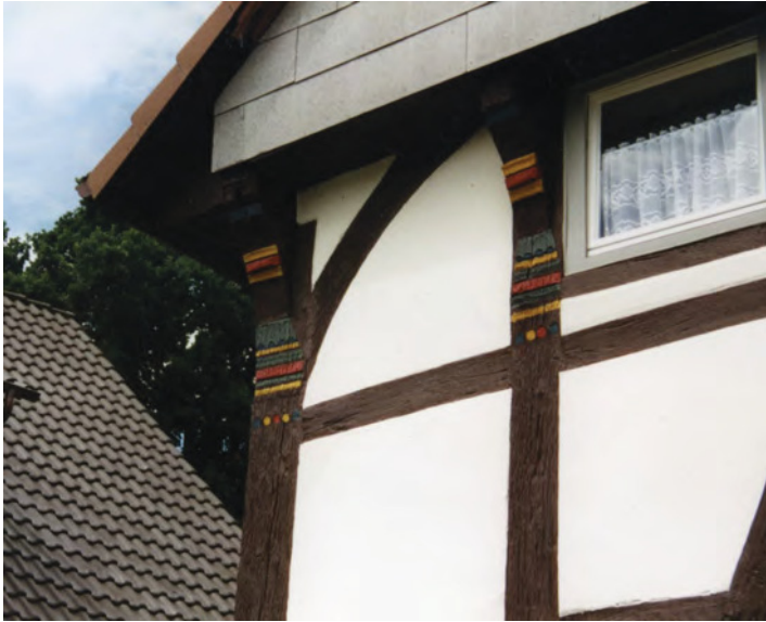
Polle, Mohrgasse 2, Knaggen am Giebel Auslucht
