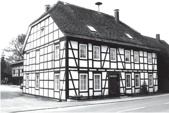
Scharfoldendorf, Mühlenstraße 2, Wohnhaus von 1854 i, nördliche Traufansicht
