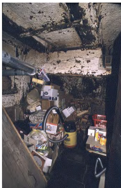
Derental, An der Kirche 7, ehem. Küchenlucht und Rauchfang in der Küche.
