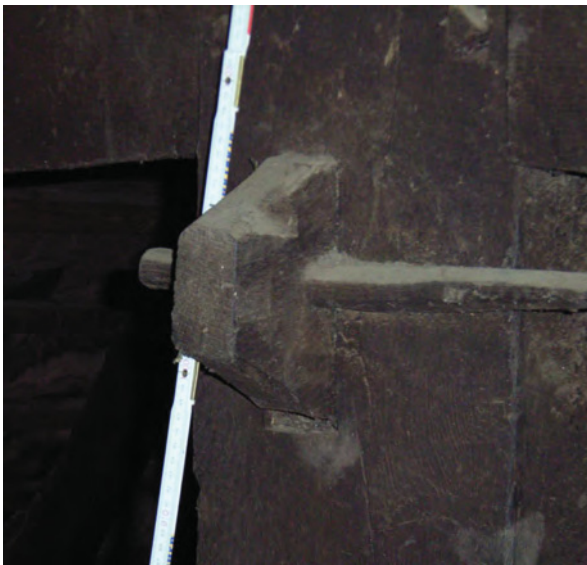
Bevern, Forster Str. 16, Dreistöckergebäude von 1555d, S-Giebel, Spitzsäule mit Zapfenschloss
