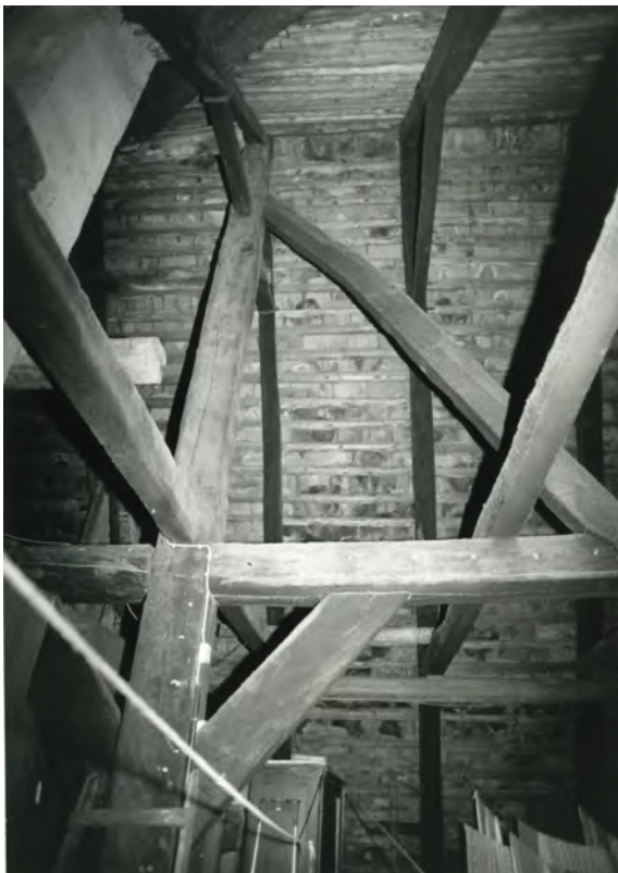
Bevern, Breslauer Str. 3, Spitzsäulendachwerk
