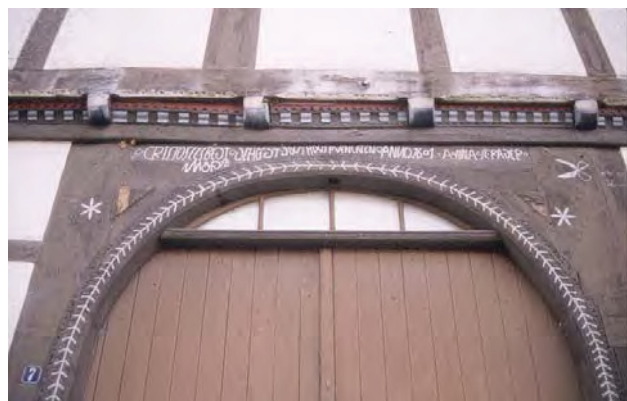
Abb. 26: Wohnwirtschaftsgebäude von 1601 i, Torbogen, Kemnade, Ringstr. 7.
