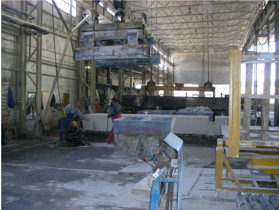
Abbildung 29: Herstellung von Baustoffen für den regionalen Verkauf. Mangelnde Sicherheitsstandards sind überall deutlich ebenso wie veraltete Technik (eigene Aufnahme 2007)
