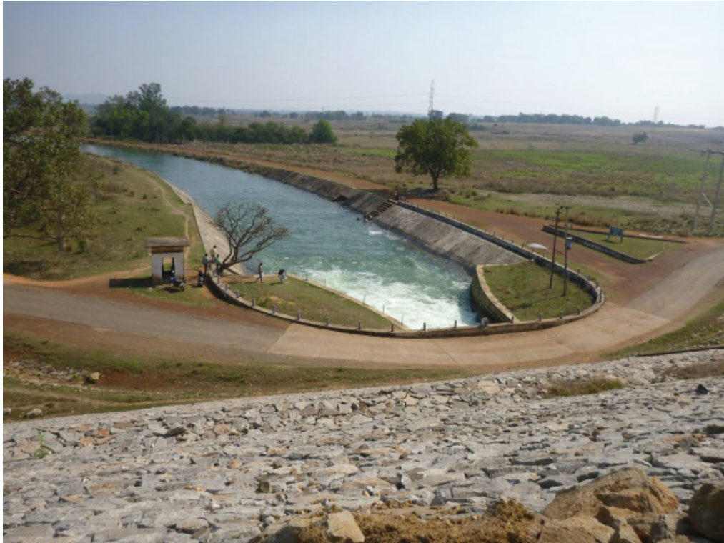
Abbildung 25 Wasserzufluss vom Hirakud-Damm in den Sason-Kanal (Quelle: Brinkschröder 2012)
