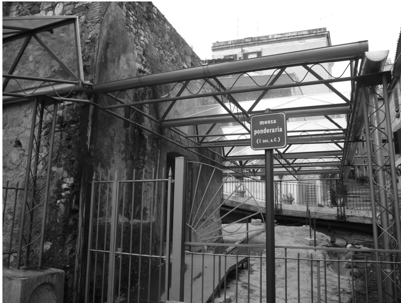
Abb. 1: Das Gebäude, in dem sich die beiden mensae ponderariae in Tivoli befinden. Die mensae stehen etwa 3 m unter dem heutigen Straßenniveau. (Su concessione del MiBAC, Istituto autonomo “Villa Adriana e Villa d’Este”)
