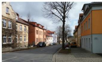
Wohn- und Mischnutzung nördlich angrenzend
