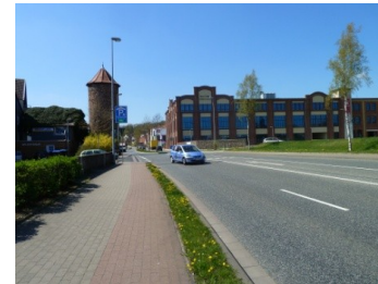
Fehlende Querungsmöglichkeit im östlichen Bereich
