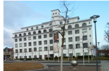
Sanierter Altbau (sog. Hochhaus)
