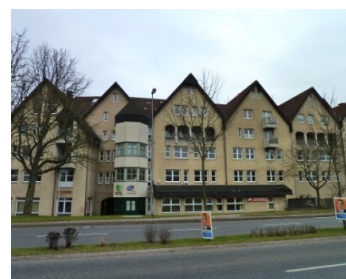
... „Stadthaus“ als geschlossene Struktur mit fehlender Durchlässigkeit zur Innenstadt
