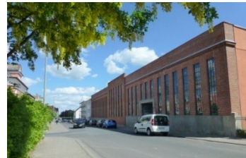
Sanierte, denkmalgeschützte Fassade
