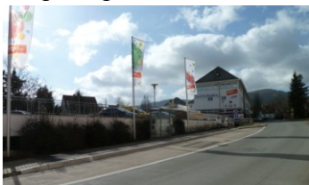
Einzelhandel- und Dienstleistungsnutzungen in der Südstadtgalerie südlich des Quartiers
