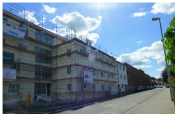
Neubauprojekt im direkten Projektumfeld
