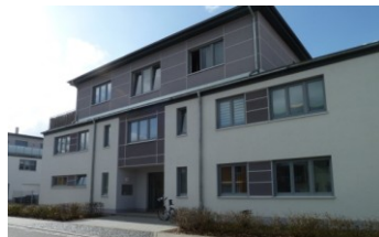
Neubau Mehrfamilienhaus im Süd-Westen des Quartiers
