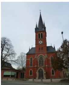
St. Lullus-Sturm als fernwirksames Gebäude
