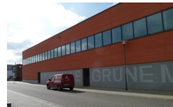
Neubau der Dreifeldsporthalle
