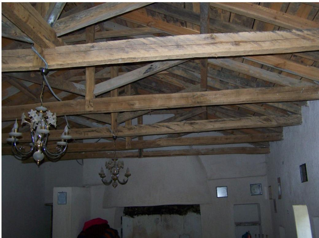
**Abbildung 49: Die Dachkonstruktion des Meydan-Evi**
