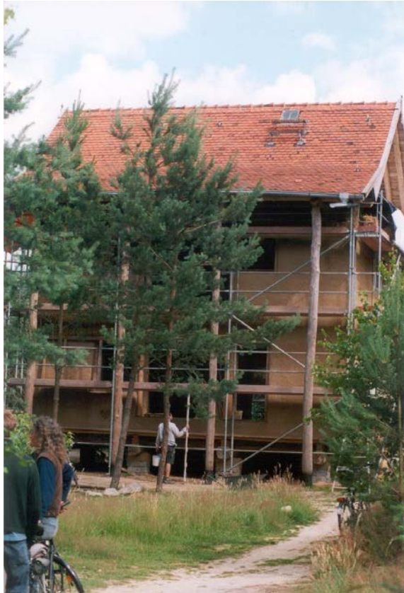
Abb.11: Das Strohballehaus des Club 99: Als Baustoffe werden Lehm und Holz vom eigenen Gelände verwendet, Recycling-Fenster und gebrauchte Ziegel wurden aus der Region gespendet. Der Bau erfolgt ohne Maschinen. Das zweistöckige Wohnhaus wird voraussichtlich Anfang 2003 fertiggestellt sein (vgl. Internet CLUB 99) (Foto: Iris Kunze, Juni 2002).
