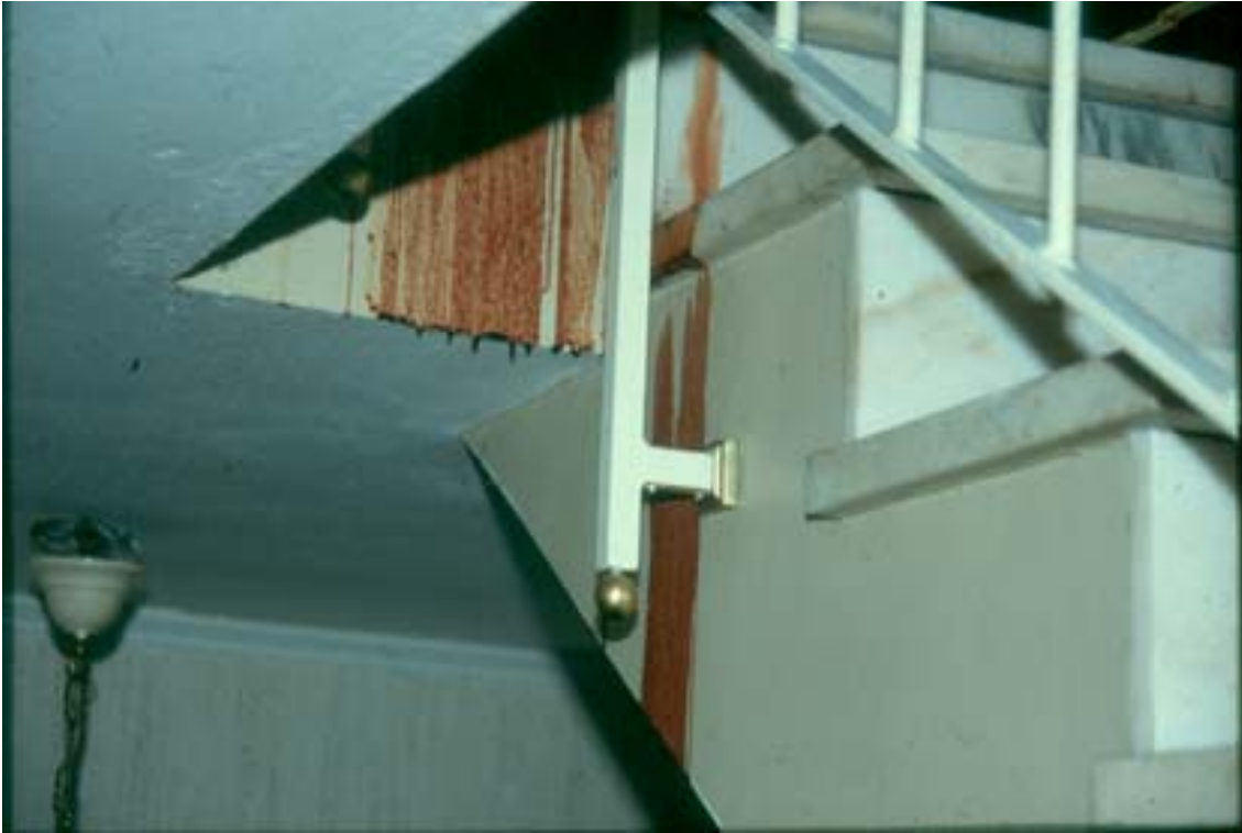
Abb. 94, Treppe ins Erdgeschoss
