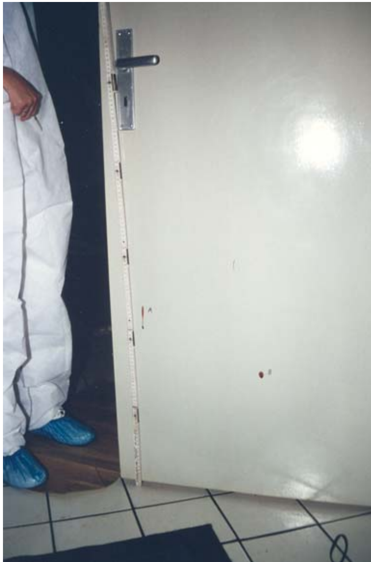
Abb. 47, Außenseite der Badezimmertür
